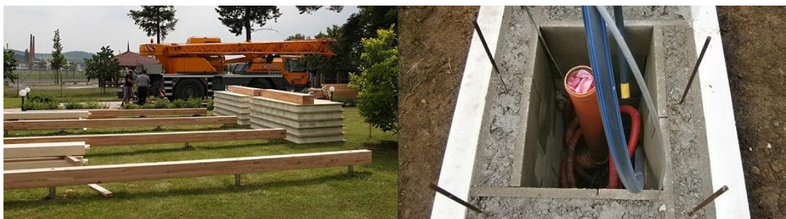
Obrázek 25 Založení na zemních vrutech a instalační šachta [28]
