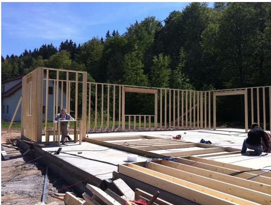
Obrázek 19 Rámová stavba letmá montáž [21]
