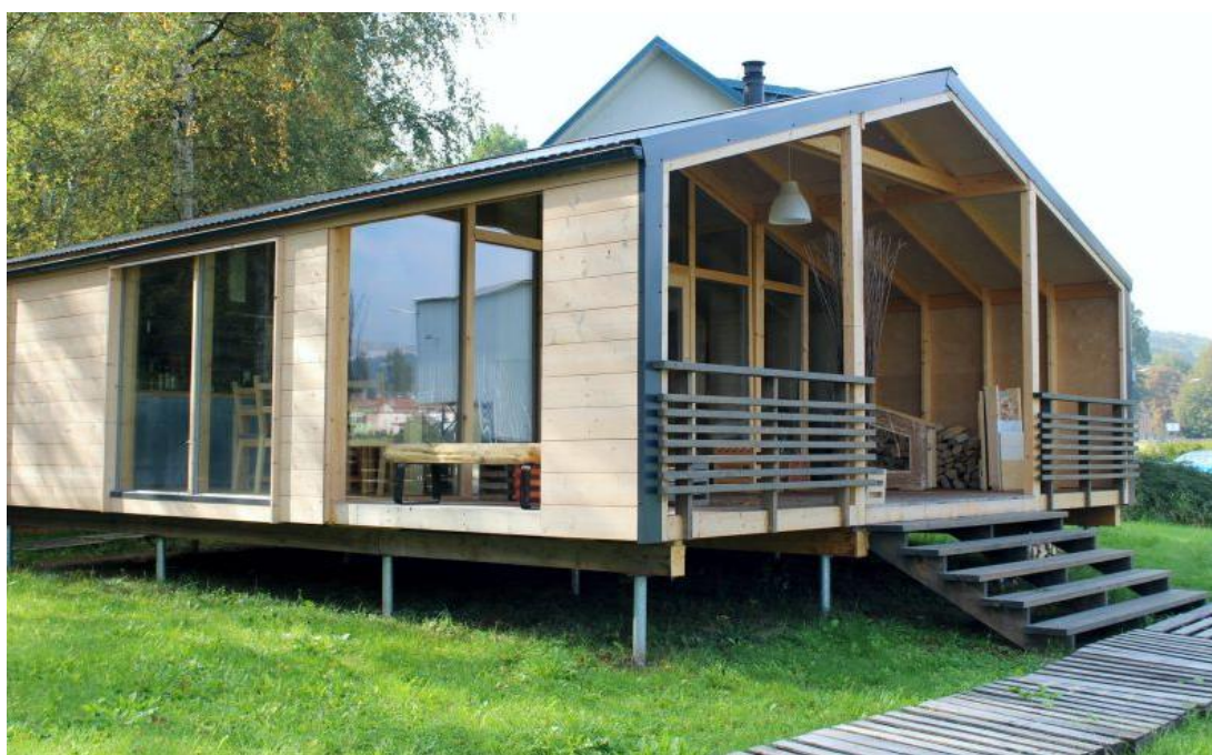
Obrázek 26 Založení domu na zemních vrutech [29]
