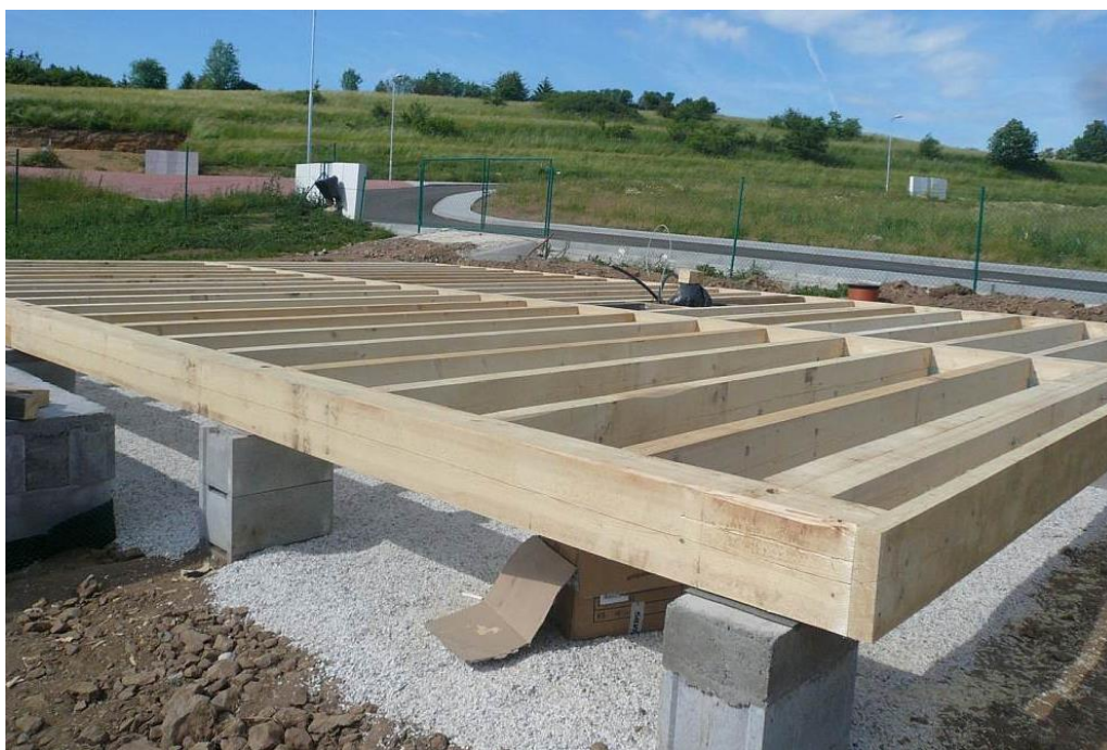
Obrázek 27 Založení na základových patkách [25]
