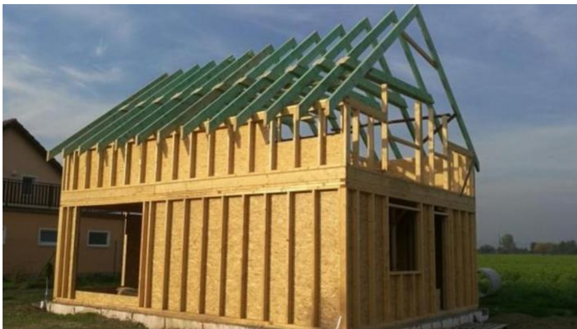
Obrázek 38 Krov z příhradových vazníků [38]
