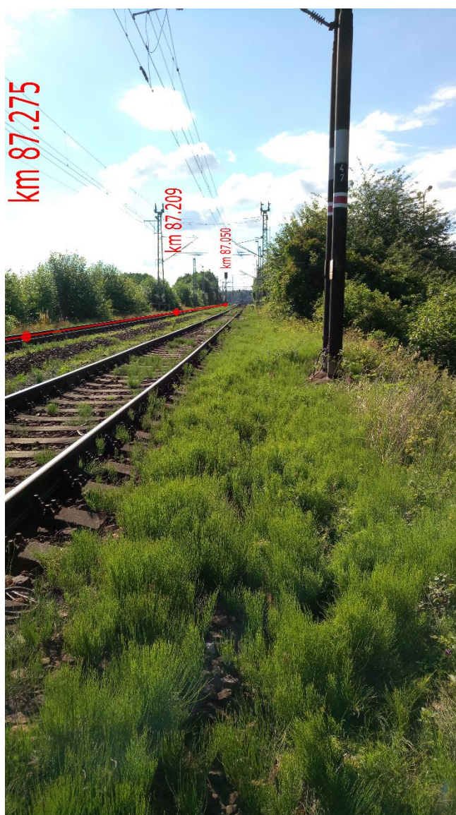
Obr. 7.3 PŮVODNÍ STAV ÚSEKU PŘED SANACÍ
