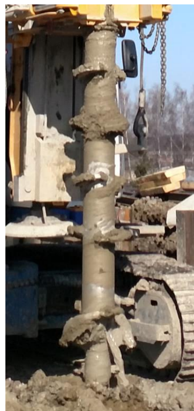
Obr. 6.12 PRACOVNÍ NÁSTROJ PRO DSM
