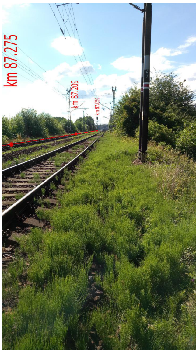
Obr. 7.3 PŮVODNÍ STAV ÚSEKU PŘED SANACÍ
