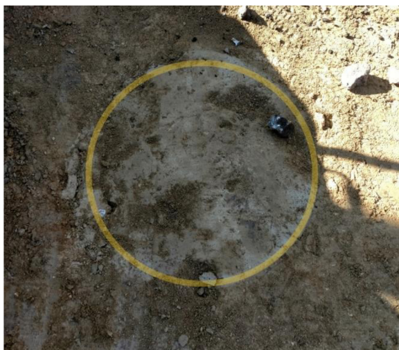
Obr. 6.13 HLAVA DSM PILÍŘE
