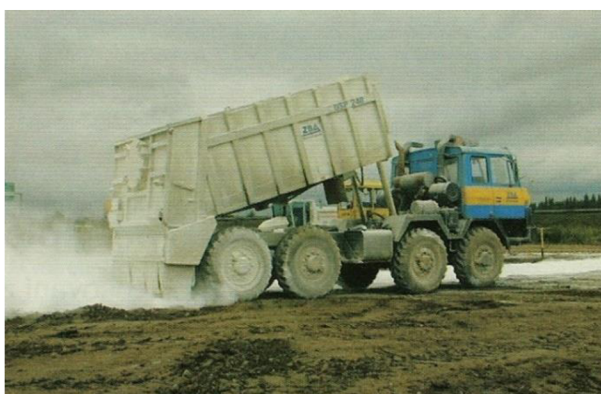
Obr. 4.1 DÁVKOVÁNÍ PŘÍMĚSI [23]
