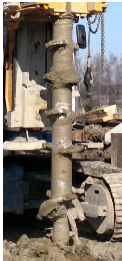
Obr. 6.12 PRACOVNÍ NÁSTROJ PRO DSM
