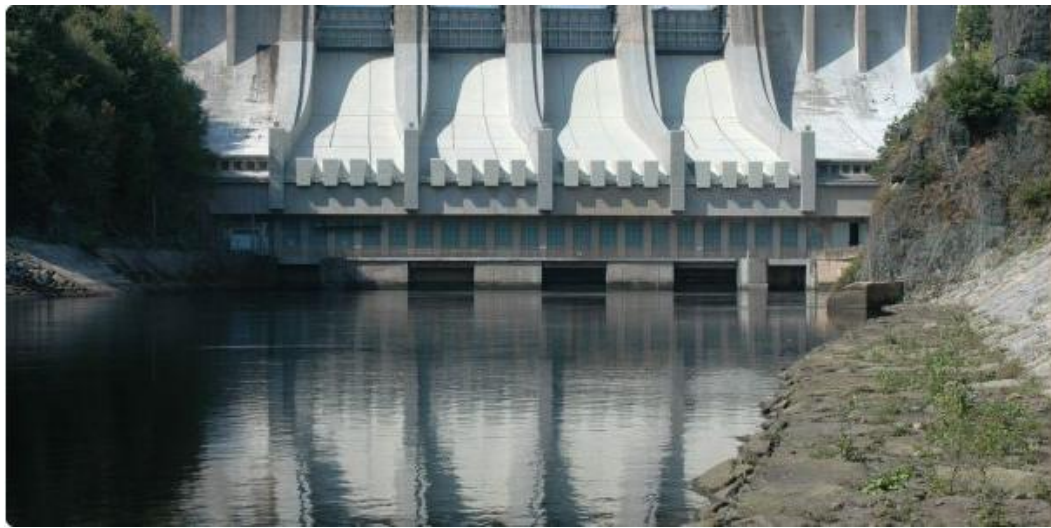
Obr. 4 Vodní dílo Slapy (Vodní elektrárna Slapy, 2020)
