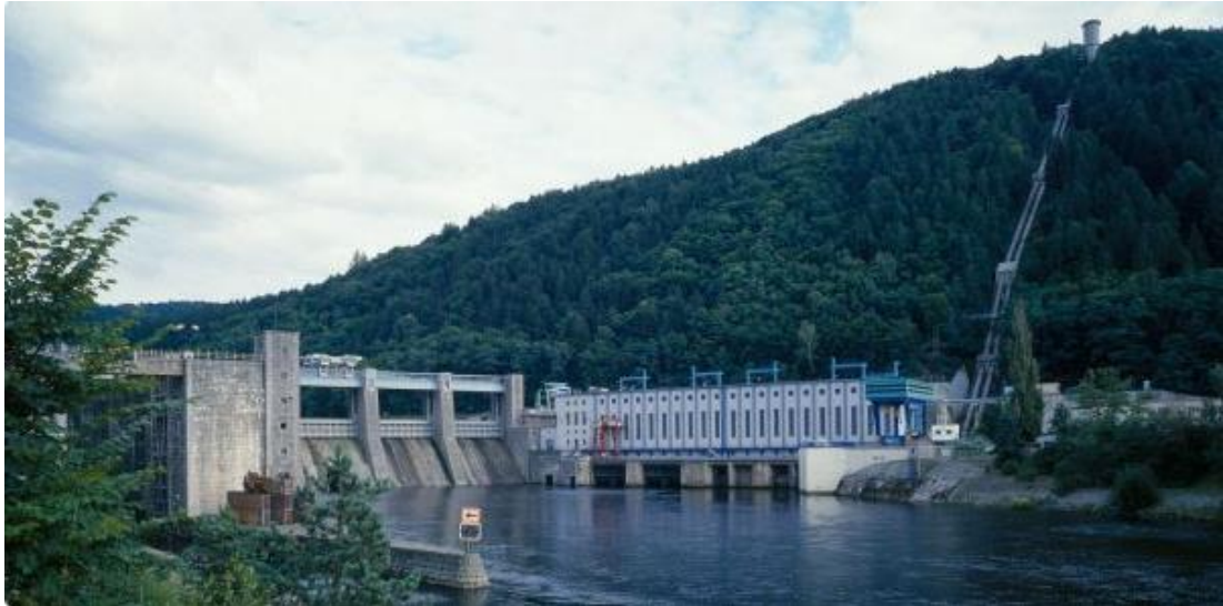
Obr. 5 Vodní dílo Štěchovice (Vodní elektrárna Štěchovice, 2020)
