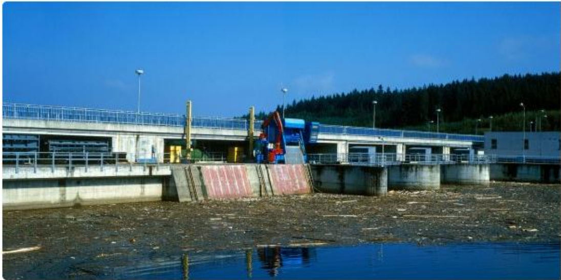
Obr. 3 Vodní dílo Hněvkovice (Vodní elektrárna Hněvkovice, 2020)
