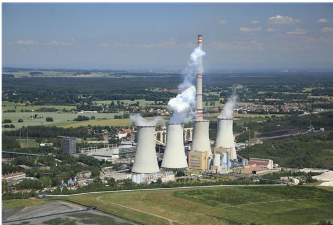
Obr. 1 - Pohled na elektrárnu Chvaletice [7]
