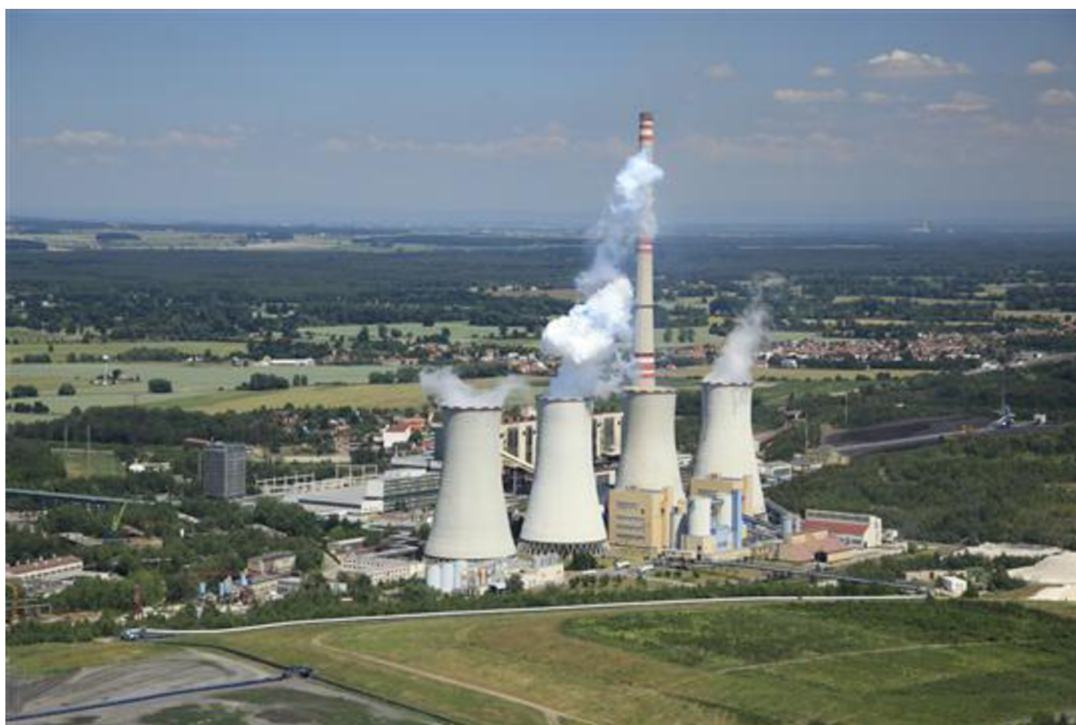
Obr. 1 - Pohled na elektrárnu Chvaletice [7]
