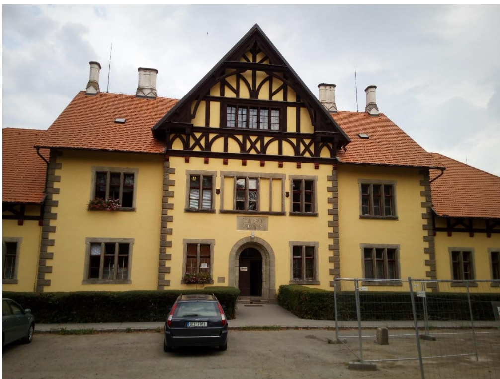
Obrázek 8 – Hřebčín Slatiňany, administrativní budova (foto autor)
