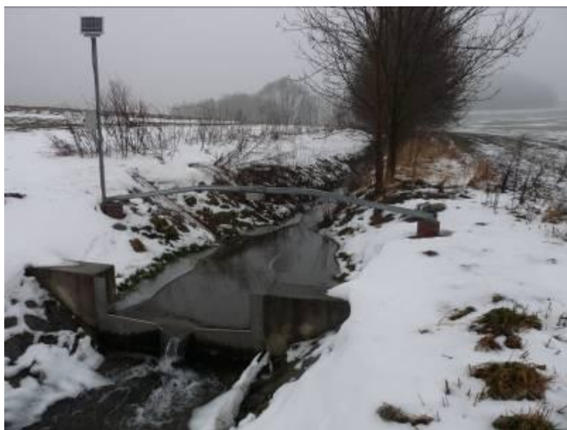
Příloha obr. 1 Měrný profil - celkový pohled
