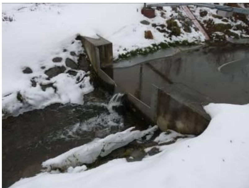
Příloha obr. 2 Měrný profil - detail přelivné hrany
