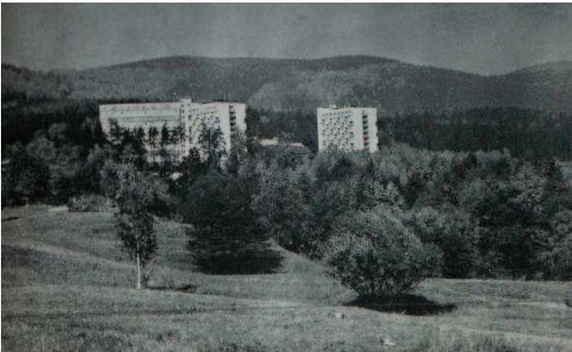
36. Kolektivní dům v Litvínově – pohled od jihu
