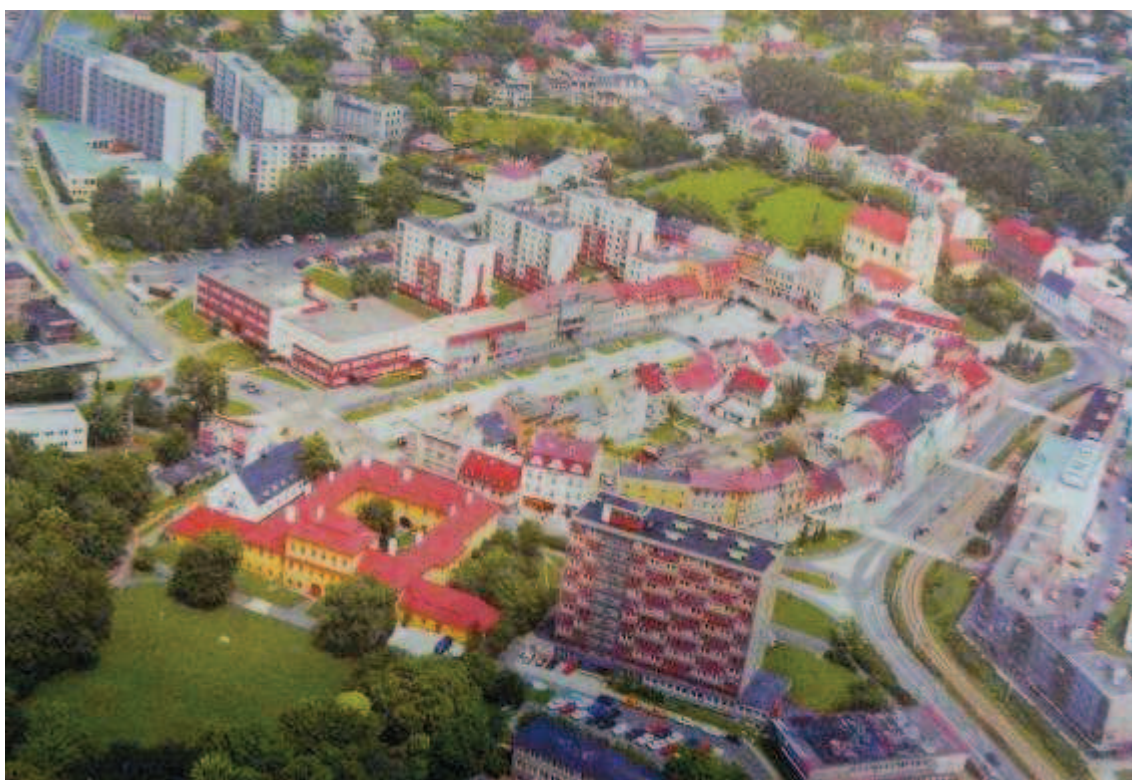
260. Centrum Litvínova – současný stav
