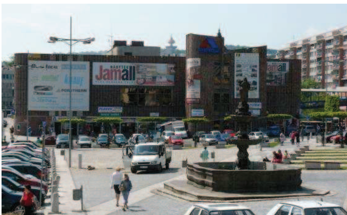
349. Jaromír Liška, Obchodní dům Prior – severní průčelí
