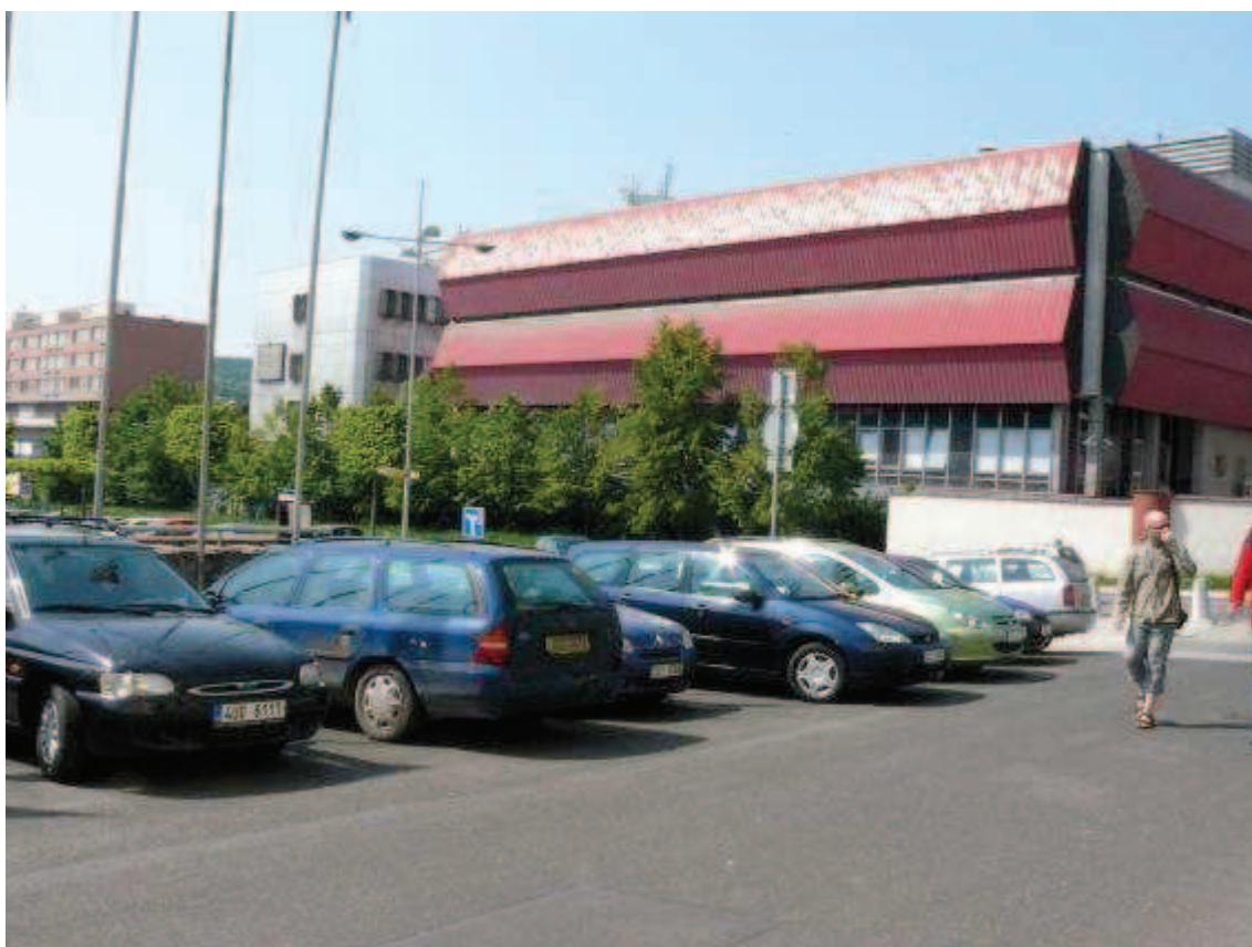
351. Jindřich Malátek, Miloš Vodolan, Telekomunikační budova, 1988
