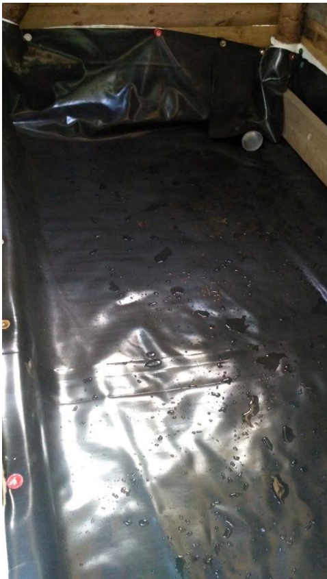
Obrázek 47: Instalace jezírkové fólie.
