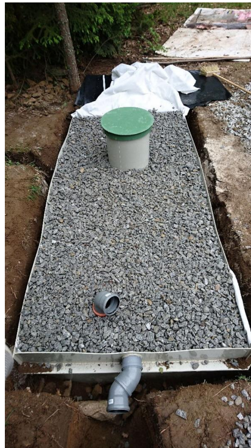
Obrázek 35: Poslední vrstva šterku, průběžně probíhající obsyp prosátou zeminou.
