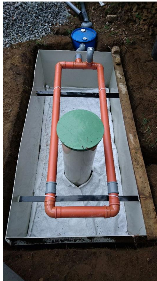
Obrázek 32: Geotextilní kryt před pískovou náplní.
