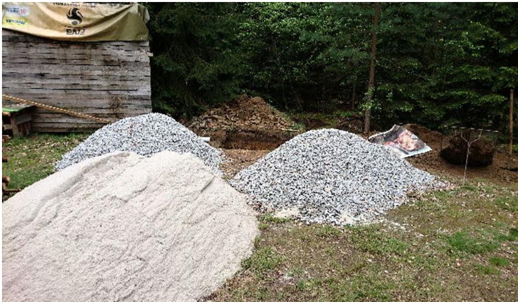
Obrázek 30: Prosévání zeminy, navážka náplně filtru.
