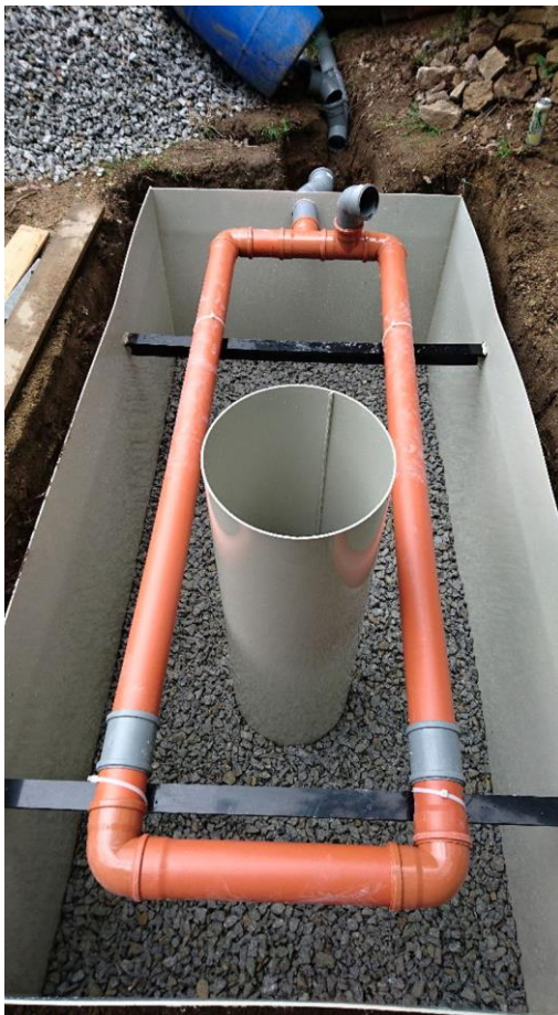
Obrázek 31: Usazení filtru, první vrstva štěrku.
