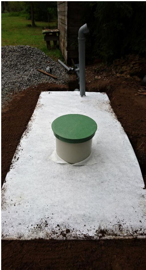
Obrázek 36: Instalace odvěšovacího potrubí, finální vrstva geotextílie.
