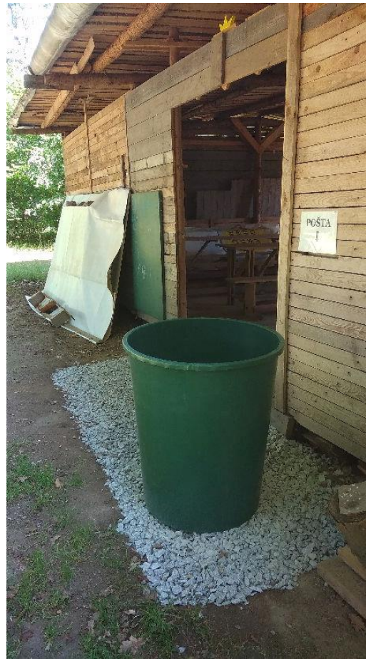
Obrázek 43: Ukázka drenáže pro odvodnění vody ze střechy.
