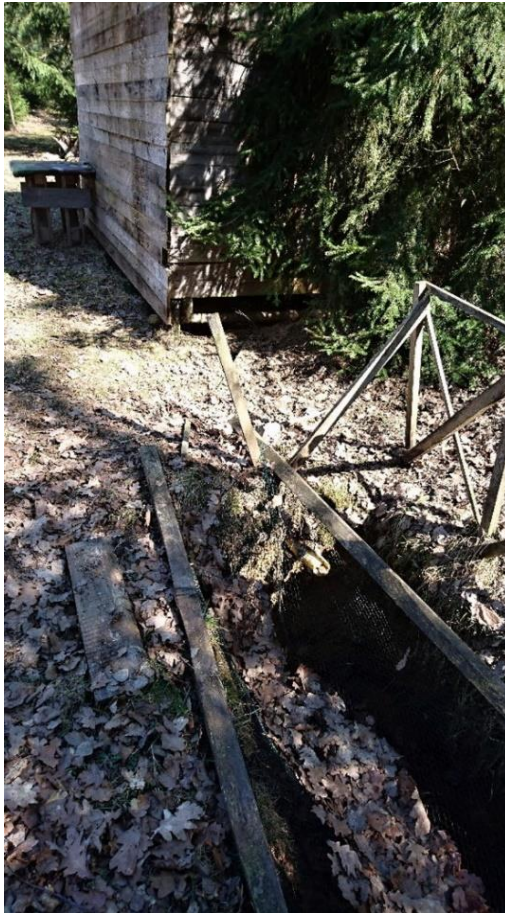
Obrázek 27: Vsakovací jáma - původní stav.
