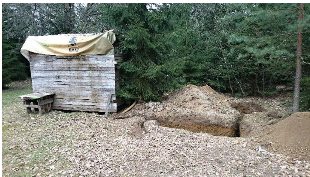
Obrázek 29: Výkopové práce, v pozadí odtoková jáma, vlevo táborová sprcha.
