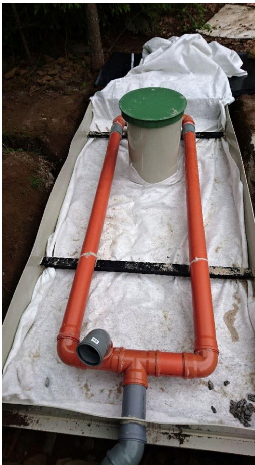
Obrázek 34: Geotextilní kryt před finální vrstvou šterku.
