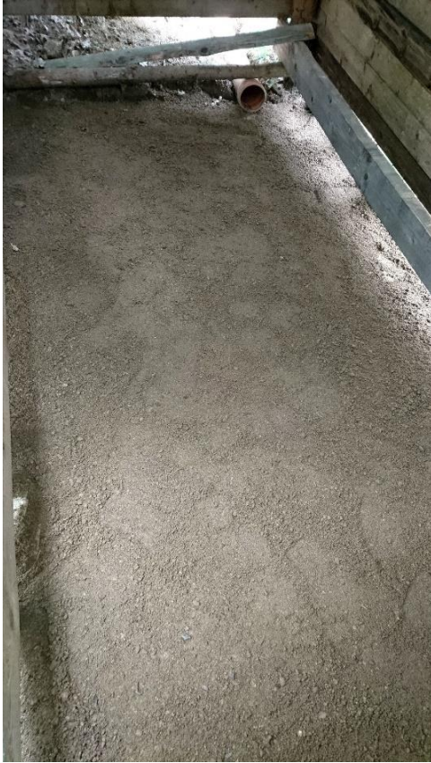
Obrázek 45: Vyspádování podkladu pro odvodnění sprchy.
