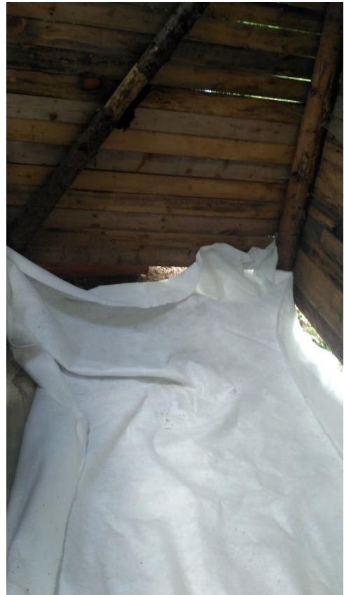
Obrázek 46: Instalace geotextilie proti poškození fólie.
