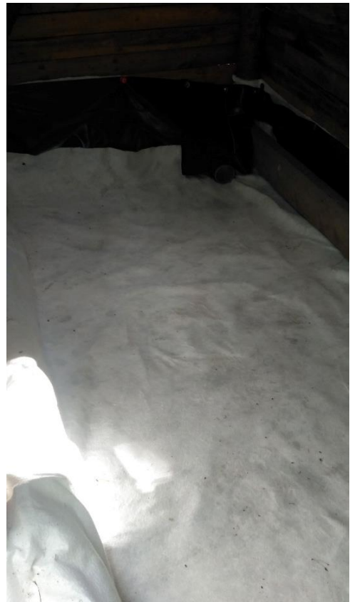
Obrázek 48: Překrytí jezírkové fólie ochranou geotextílií.
