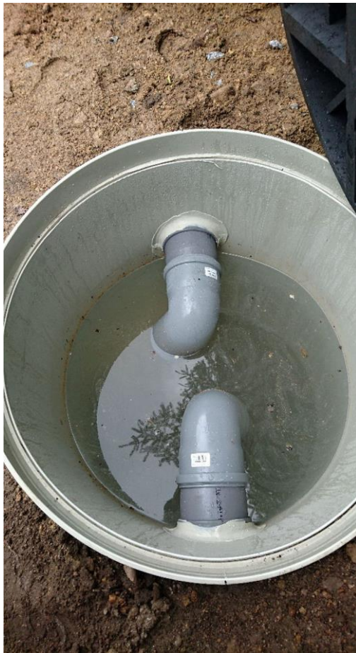
Obrázek 39: Odkalovací nádoba - umístění nátoky a odtoku.
