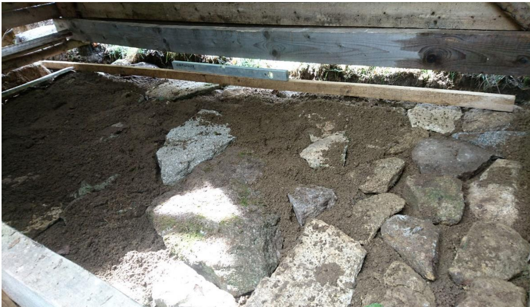
Obrázek 44: Příprava podkladu odvodnění táborové sprchy.
