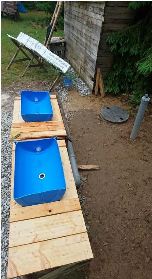
Obrázek 42: Napojení všech provozů zemního filtru.
