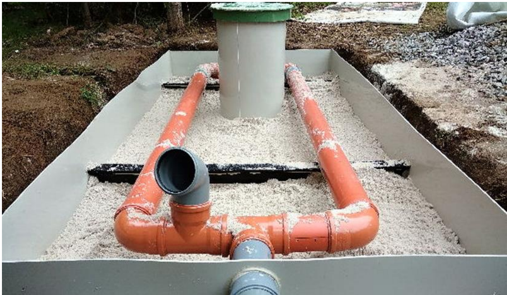
Obrázek 33: Kompletace pískové náplně.
