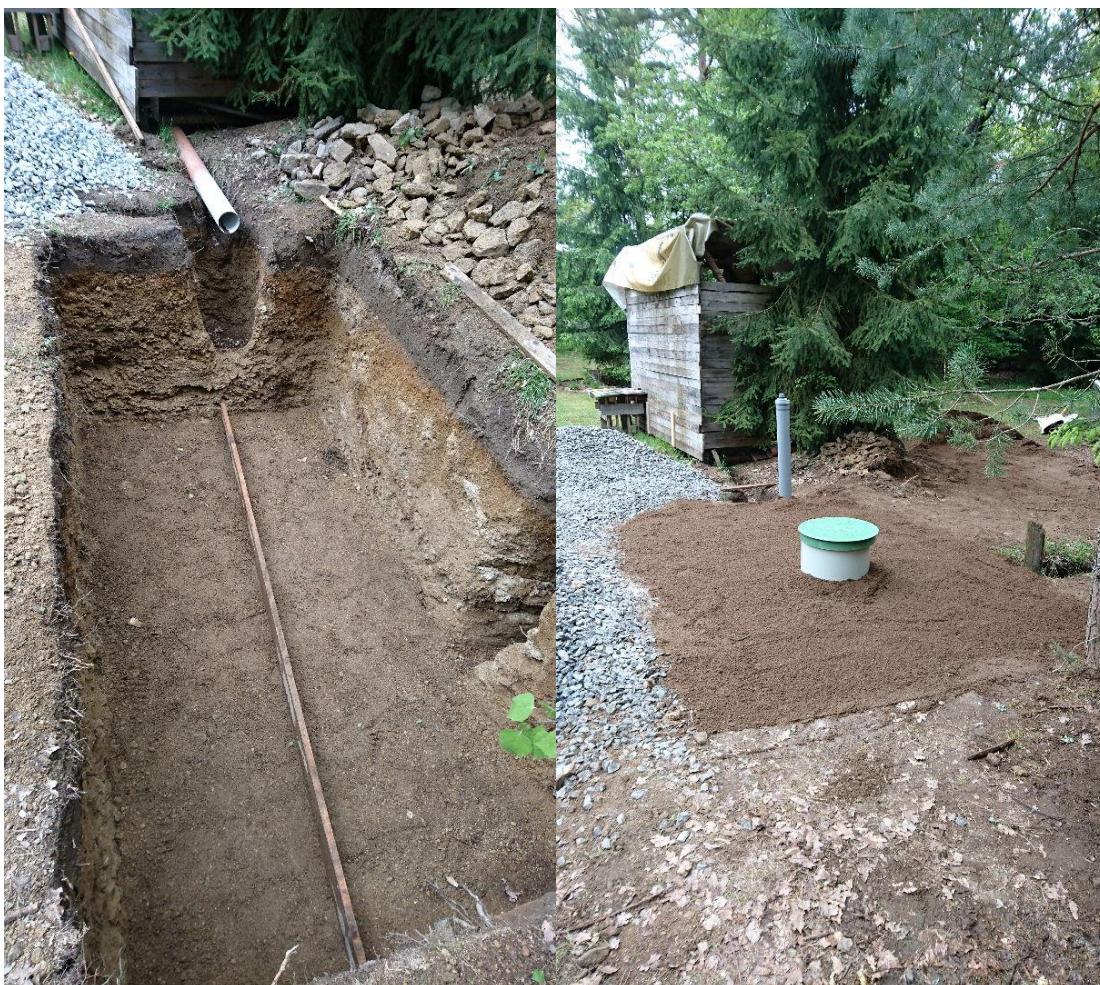
Obrázek 16: Realizace experimentálního zemního pískového filtru, vlevo výkopové práce před usazením filtru, vpravo finální úprava po usazení.
