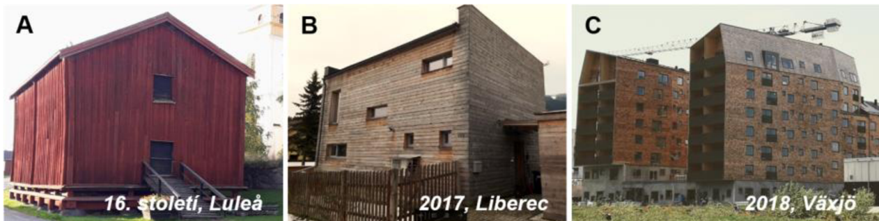
Obrázek č. 1 – Dřevěný fasádní obklad: A – open-joint barn technique v Gammelstads Kyrkstad; B - rodinný dům s fasádním obkladem ze sibiřského modřínu; C – bytové domy s obkladem z modřínových šindelů;
