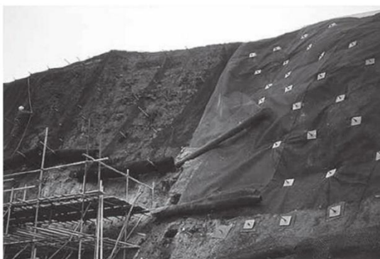
Obrázek 1.46: Přírodní geotextilie pro ochranu svahů proti erozi (Kozłowski, 2012)
