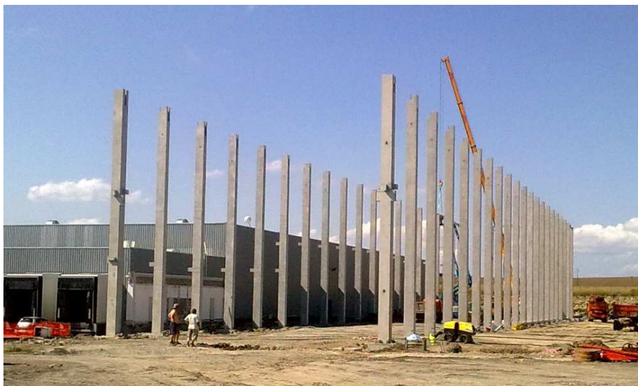
Obr. 4.1 – Osazené sloupy vysoké skladovací haly SO 920
