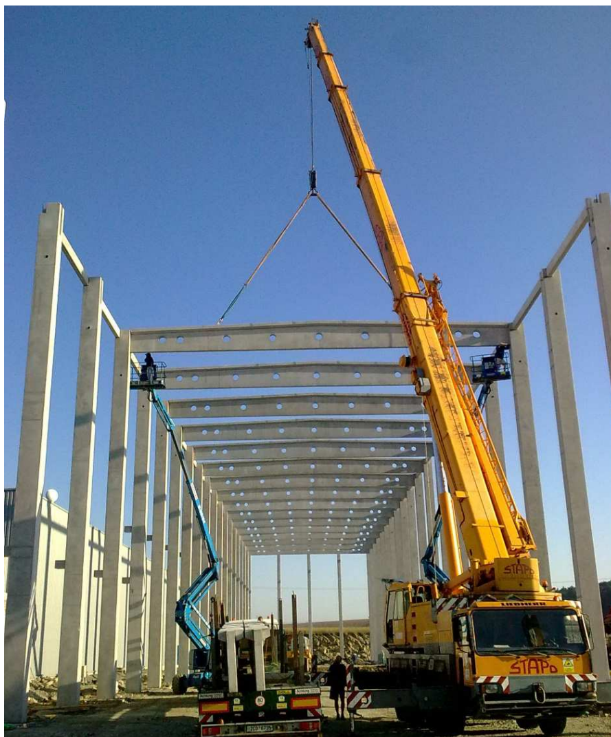
Obr. 4.3 – Montáž střešního vazníku
