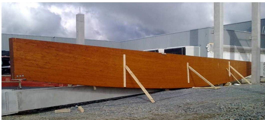
Obr. 5.1 – Skladování vazníku
