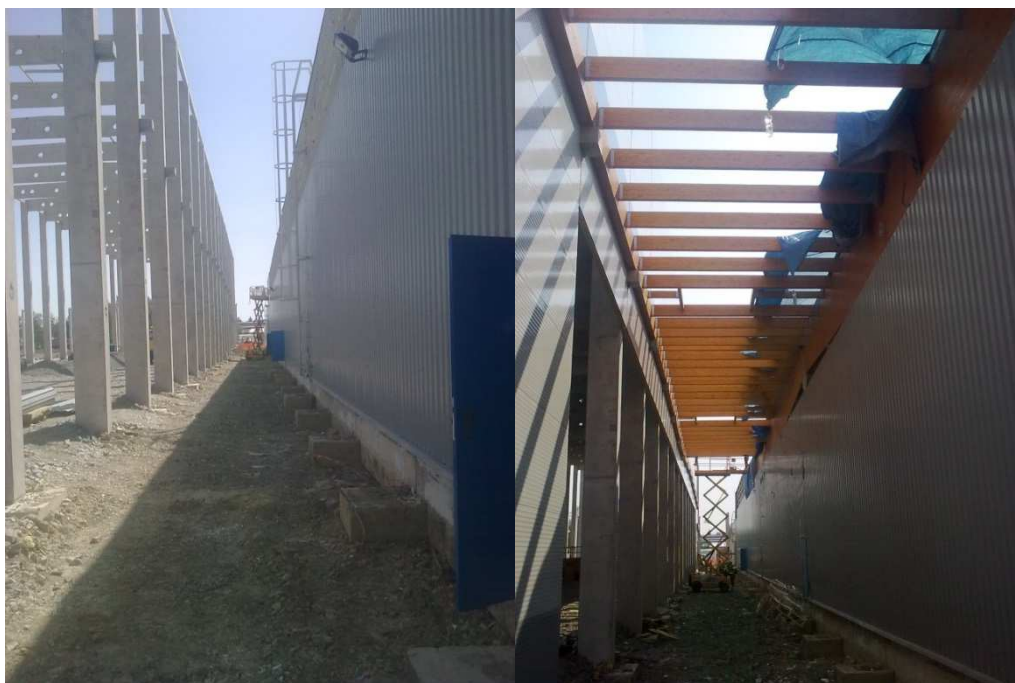
Obr. 5.2 – Spojovací modul před a po zhotovení střešní konstrukce
