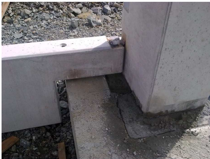
Obr. 4.2 – Osazení základového nosníku
