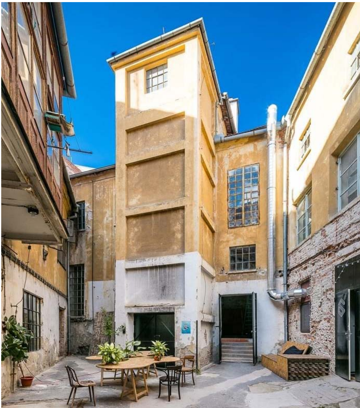
Obr. 54: Vstupní prostor, tzv. „Yard“, stav z roku 2017 125
