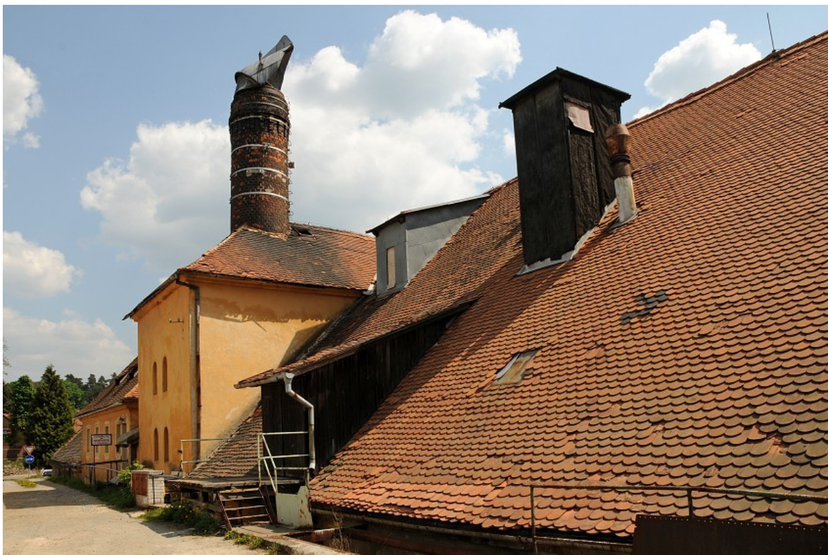
Obr. 55: Pohled na sladovnu, hvozdu a v pozadí na varnu pivovaru v Boskovicích, stav z roku 2015 128
