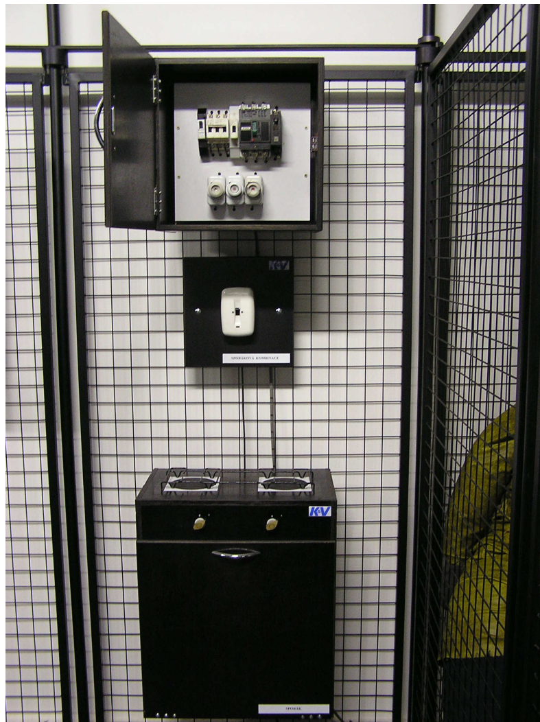
Obr. 17: koncový díl polygonu s hlavním vypínačem el.energie
