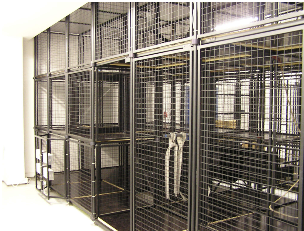
Obr. 14: Drátěné boxy modulového systému polygonu HZS Jablonec n.N.
