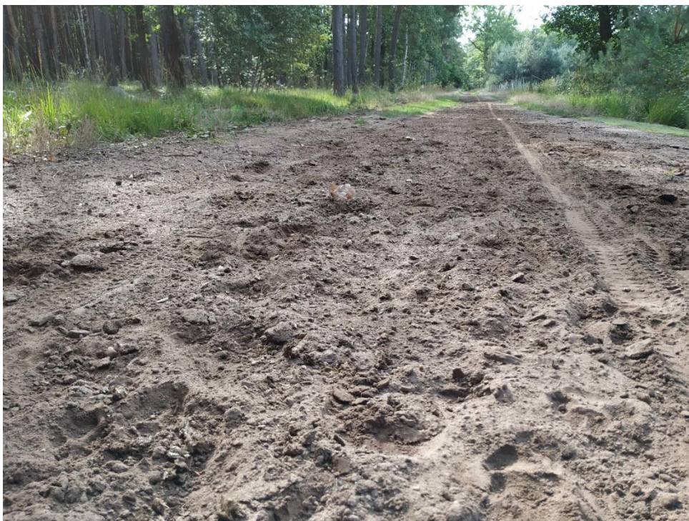
Obr. 28: Úsek cesty několika set metrů s vysokou vrstvou písku. Tato cesta je hluboká a měkká.
