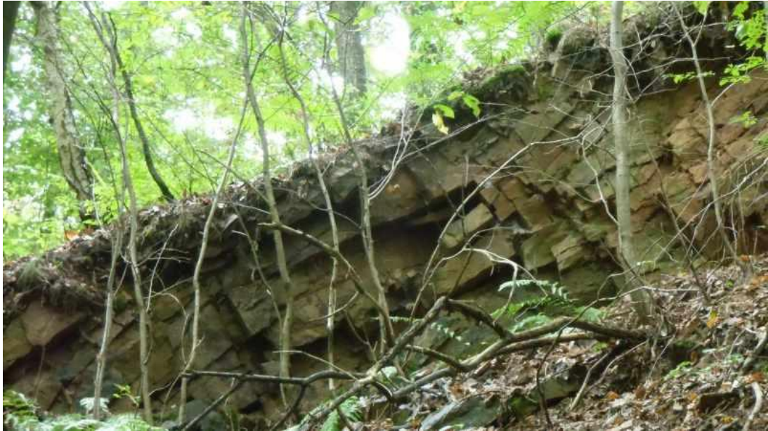
Foto 36.4 Pohled na křemencový skalní výchoz, který se nachází pod horním okrajem těžebního prostoru. Orientace na jihozápad.
