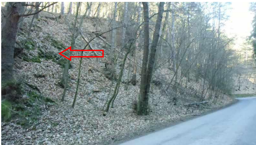
Foto 46.1 Zasazení lokality do krajiny s celkovým pohledem na lokalitu, orientace na východ. Jedná se o opuštěnou lokalitu, která sousedí s komunikací. Probíhala zde těžba křemenného pískovce (křemence).
