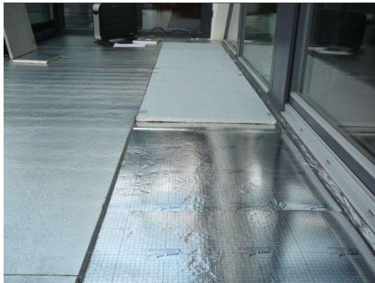
Obrázek 20: Použití vakuových izolačních panelů na podlahy [24]
