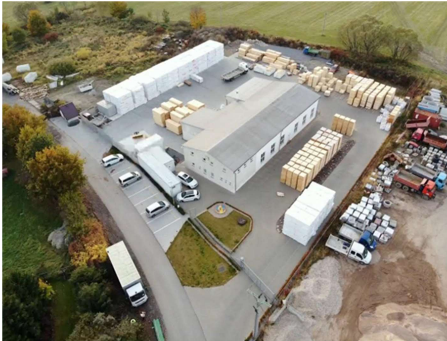
Obr. č. 2: Budova s komunikacemi a skladovacími prostory 2
