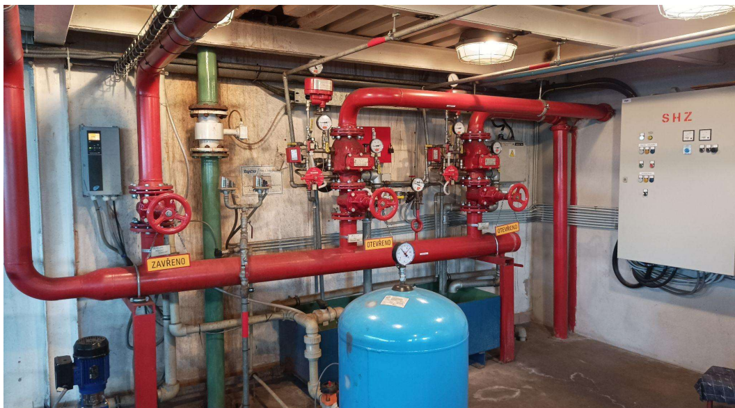
Obr. č. 8: Stabilní hasicí zařízení – zdroj: vlastní foto
