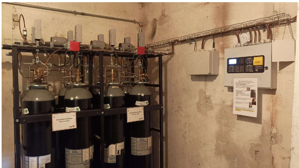
Obr. č. 14: Zásoba hasebních látky CO 2 – zdroj: vlastní foto
