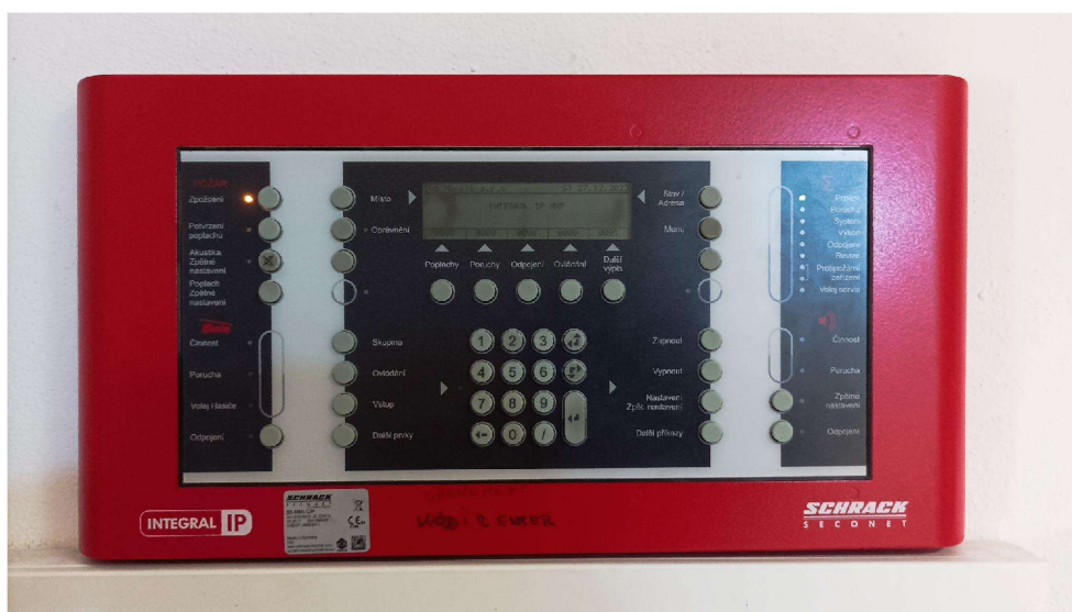
Obr. č. 6: Ústředna EPS – zdroj: vlastní foto
