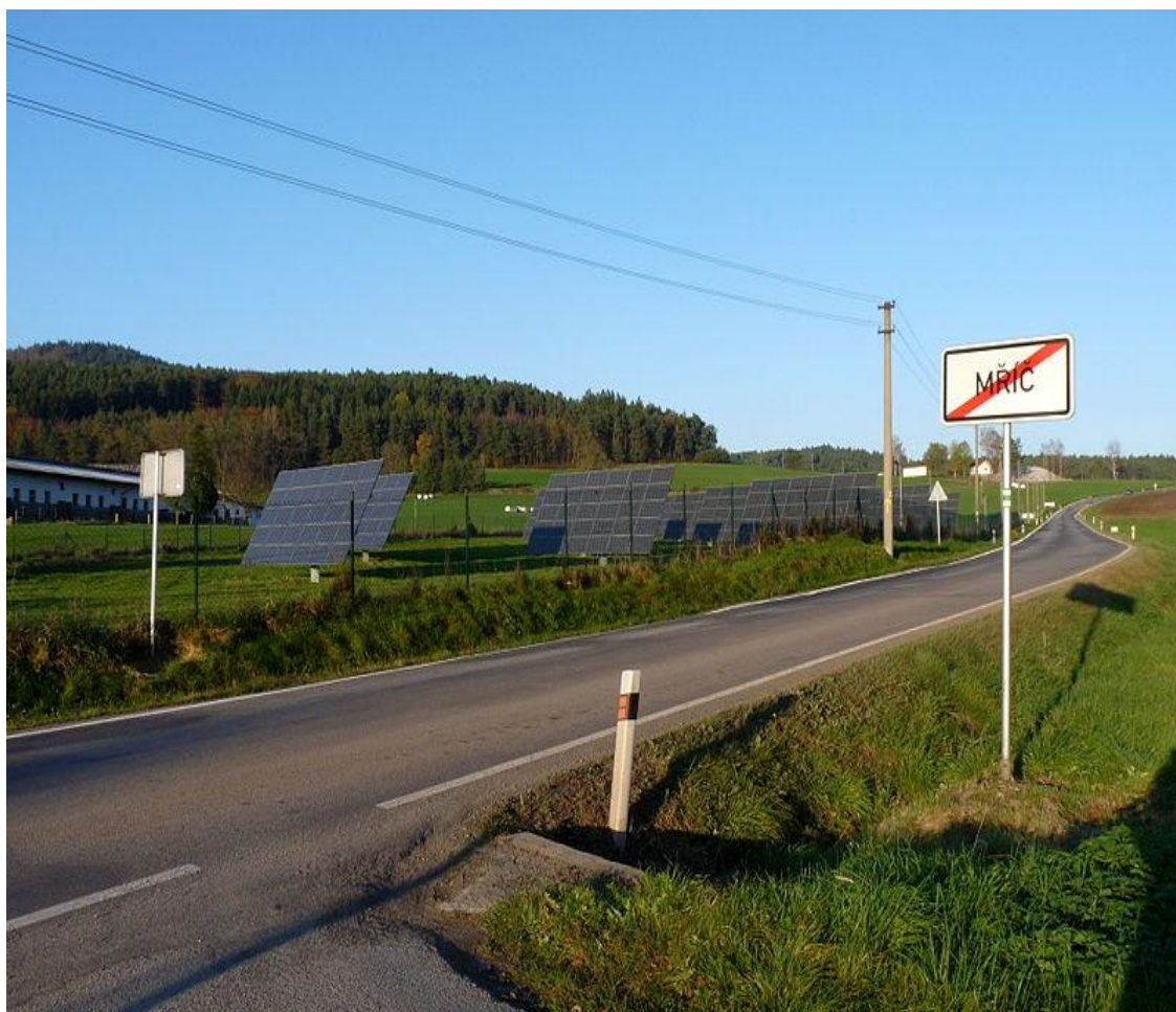
Příloha 1: Fotografický pohled na solární elektrárnu Mřič
