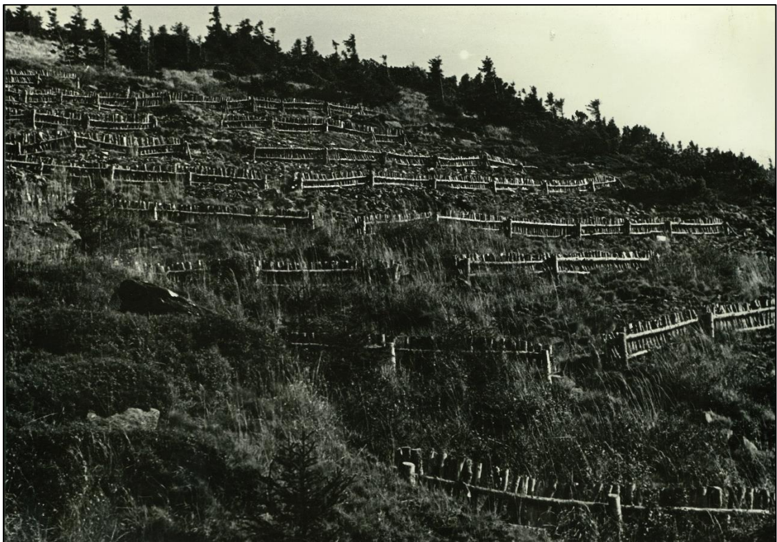
Příloha 22: Technické zajišťování ploch po svahových sesuvech - palisádové plůtky Zdroj: Sokol (1965)
