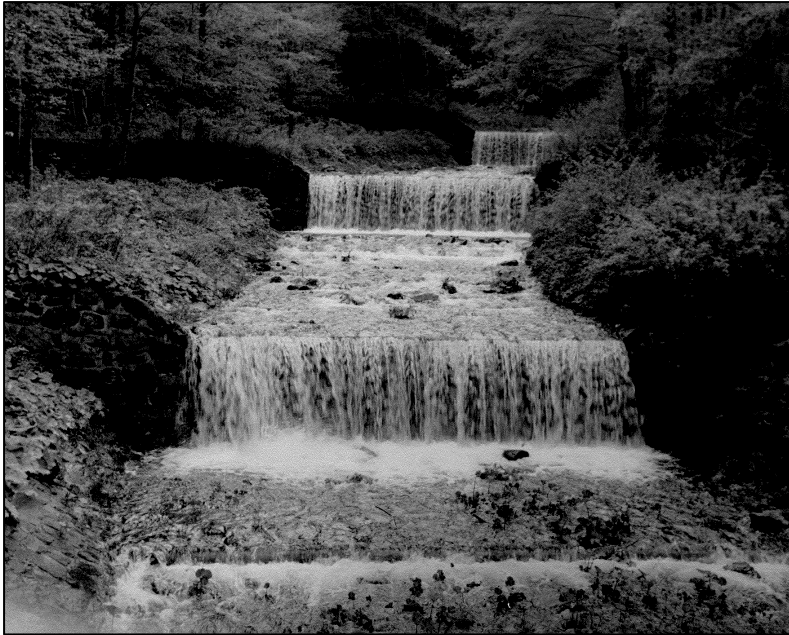
Příloha 19: Technické zajišťování koryt řek - kamenné kaskády Zdroj: Sokol (1965)
