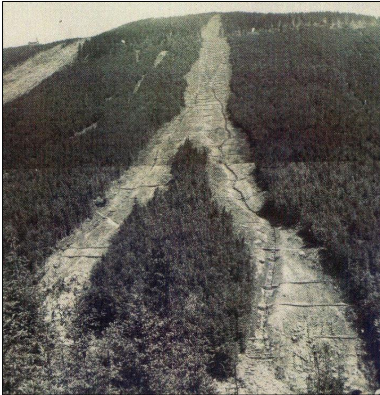
Příloha 17: Vidlicovitě větvená murová dráha č. 1 na západním svahu Červené hory po provedení technických sanačních prací v roce 1929 (číslováno podle Sokola (1965)) Zdroj: Sokol (1965)
