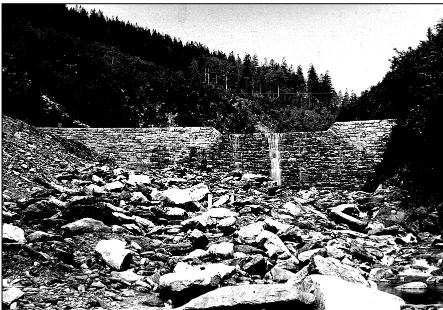
Příloha 20: Technické zajišťování koryt řek – kamenné přehrážky zachycující splaveniny ze svahů Zdroj: Sokol (1965)
