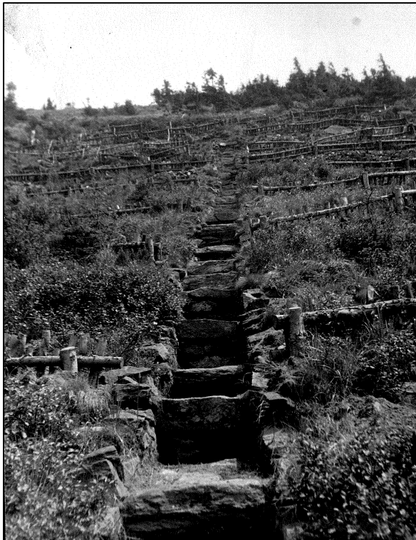
Příloha 21: Technické zajišťování ploch po svahových sesuvech - kaskádovité kamenné žlaby Zdroj: Sokol (1965)
