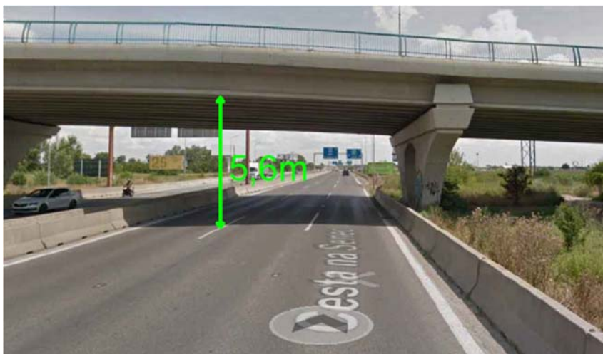
Obr. 2.5.7 Trasa dopravy systémového bednění – zájmový bod 18 – 6,6 km [3]
