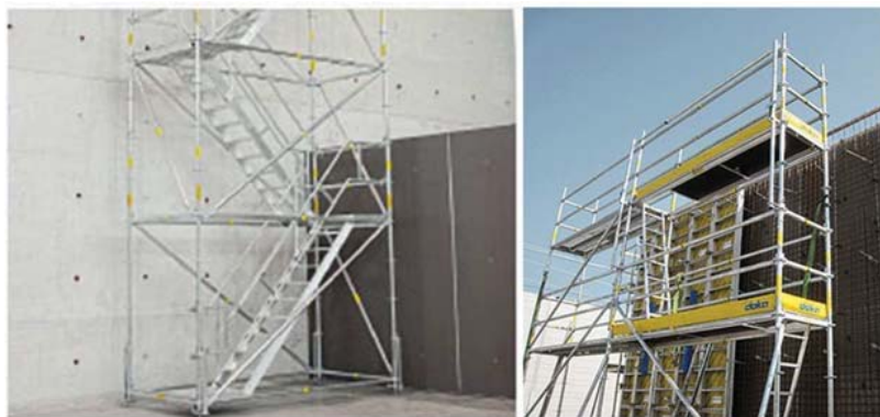
Obr. 6.2.13 Dočasné stavební konstrukce DOKA [15]
