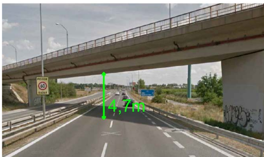
Obr. 2.5.8 Trasa dopravy systémového bednění – zájmový bod 19 [3]
