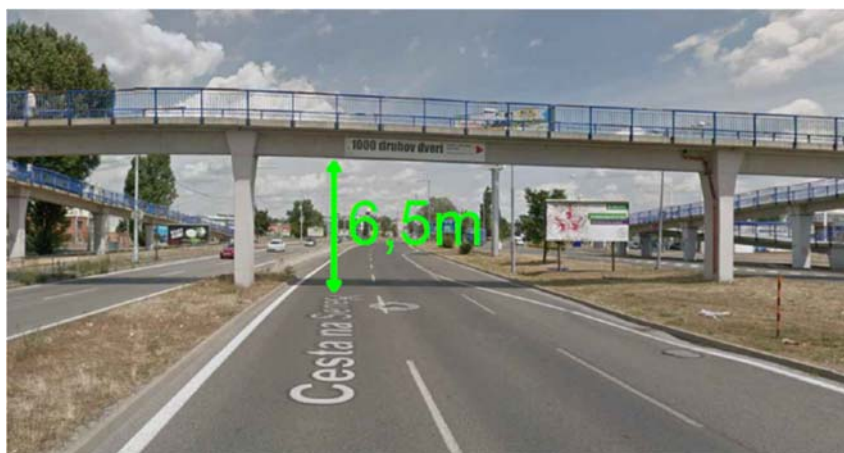
Obr. 2.5.5 Trasa dopravy systémového bednění – zájmový bod 16 – 3,7 km [3]
