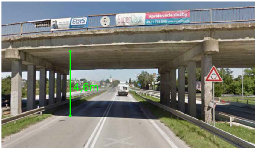
Obr. 2.5.10 Trasa dopravy systémového bednění – zájmový bod 21 – 20,0 km [3]
