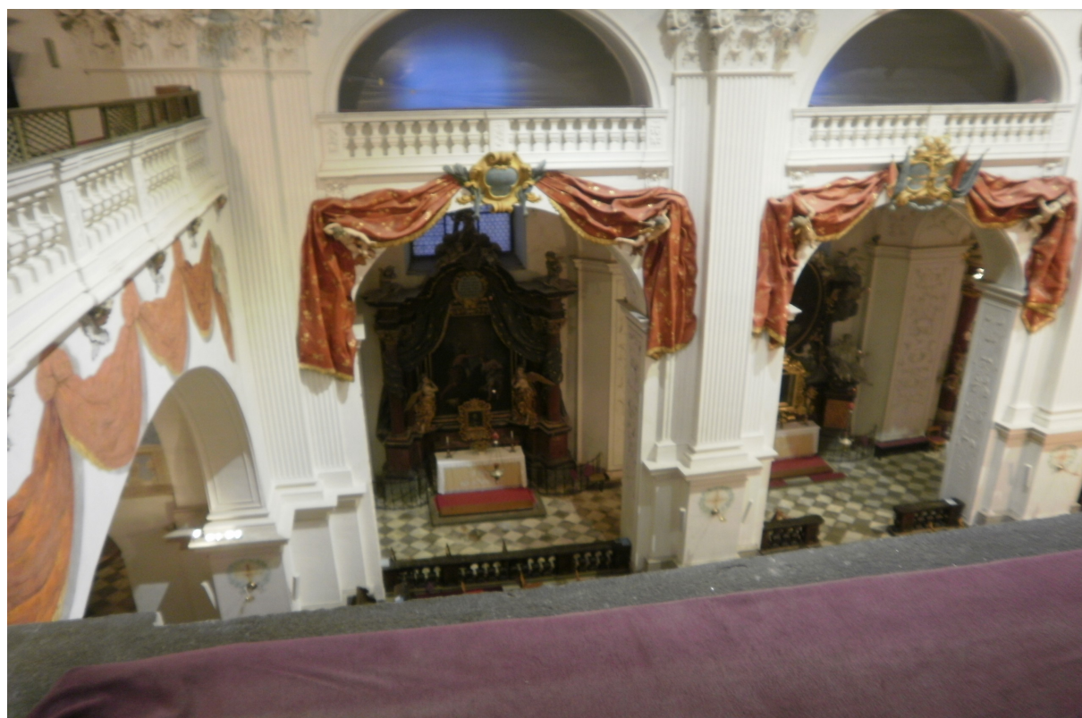
Obr.11 Křestní kaple po opravě vlevo dole na obrázku 2011
