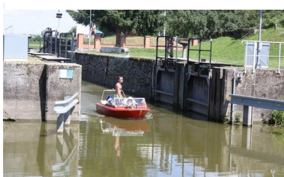
Obrázek 22: Zdymadlo po rekonstrukci
