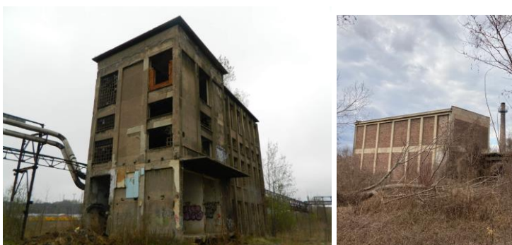
Obr. č. 52 – Trafostanice v západní části areálu
