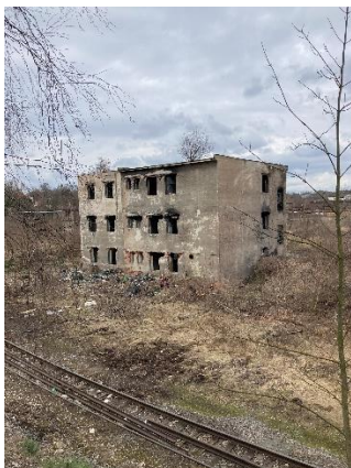
Obr. č. 51 – Bývalé šatny
