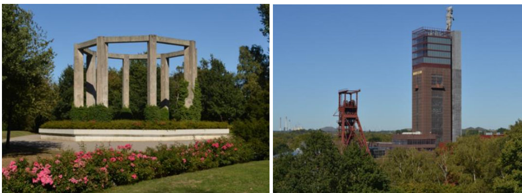
Obr. č. 4 – zbytky chladicí věže (Ruhrgebiet-industriekultur ©nedatováno)
