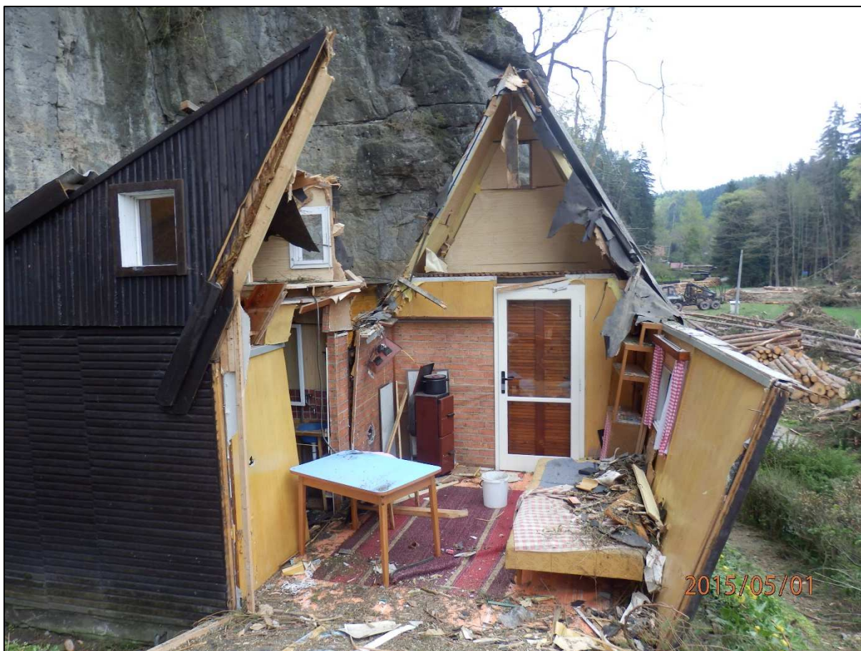
Obrázek 8.6 – Postupná demontáž objektu [vlastní zdroj]
