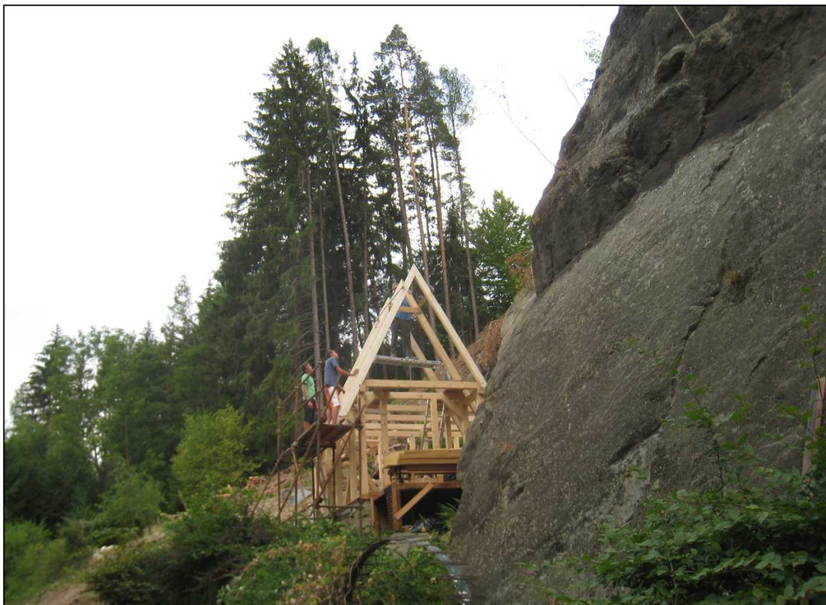
Obrázek 8.8 – Nosná konstrukce nové chaty [vlastní zdroj]
