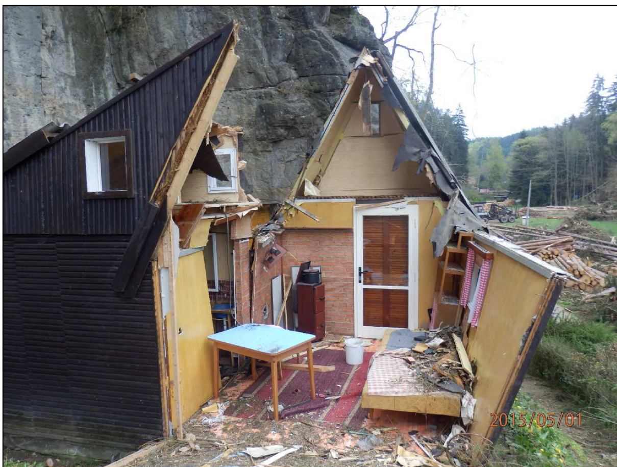
Obrázek 8.6 – Postupná demontáž objektu [vlastní zdroj]
