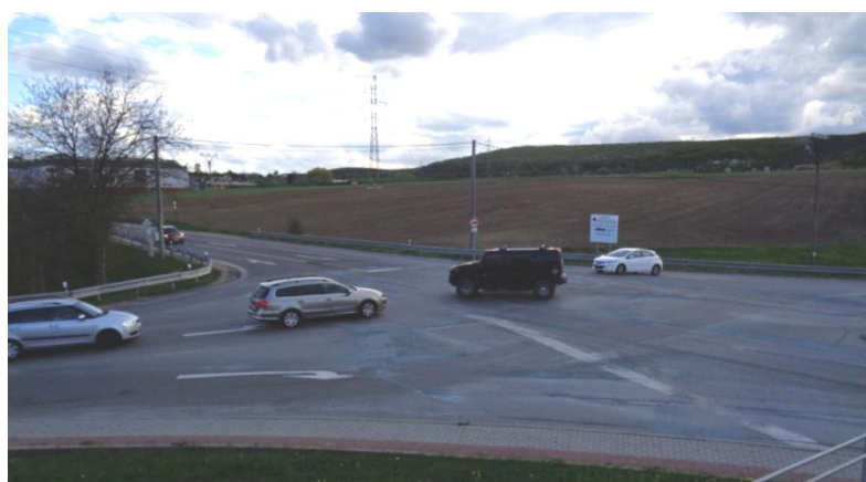
Obr. 23 Ukázka zhoršených rozhledových poměrů v dané křižovatce Zdroj: vlastní foto
