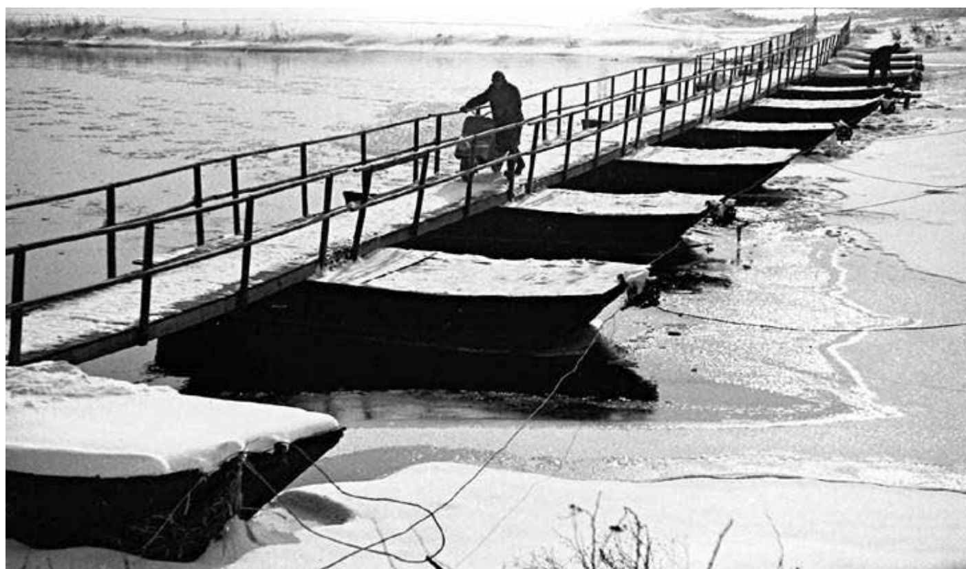
obr. 044 Pontonová lávka v Radotíně v roce 1965 (Letopisecká komise Radotín 2016). viz. Seznam grafických příloh
