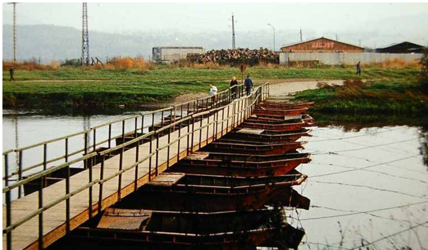
obr. 046 Pontonový most spojoval břehy od 70. let minulého století (Letopisecká komise Radotín 2021). viz. Seznam grafických příloh
