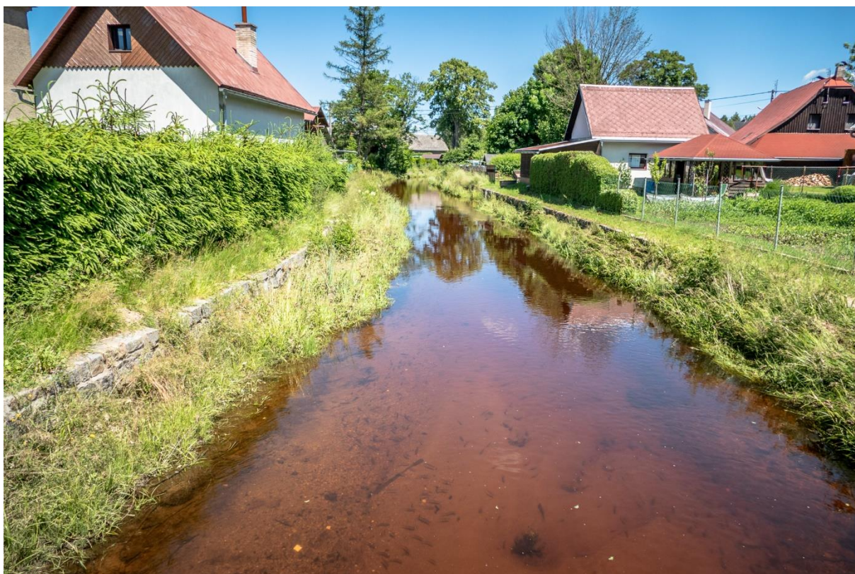
Obr. 55. Pohled z lávky L1, po p., ř. km 165,9813 [6/2020].
