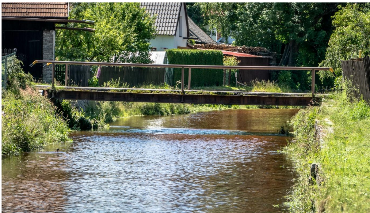
Obr. 58. M1 – Most, ř. km 165,6747 [6/2020].
