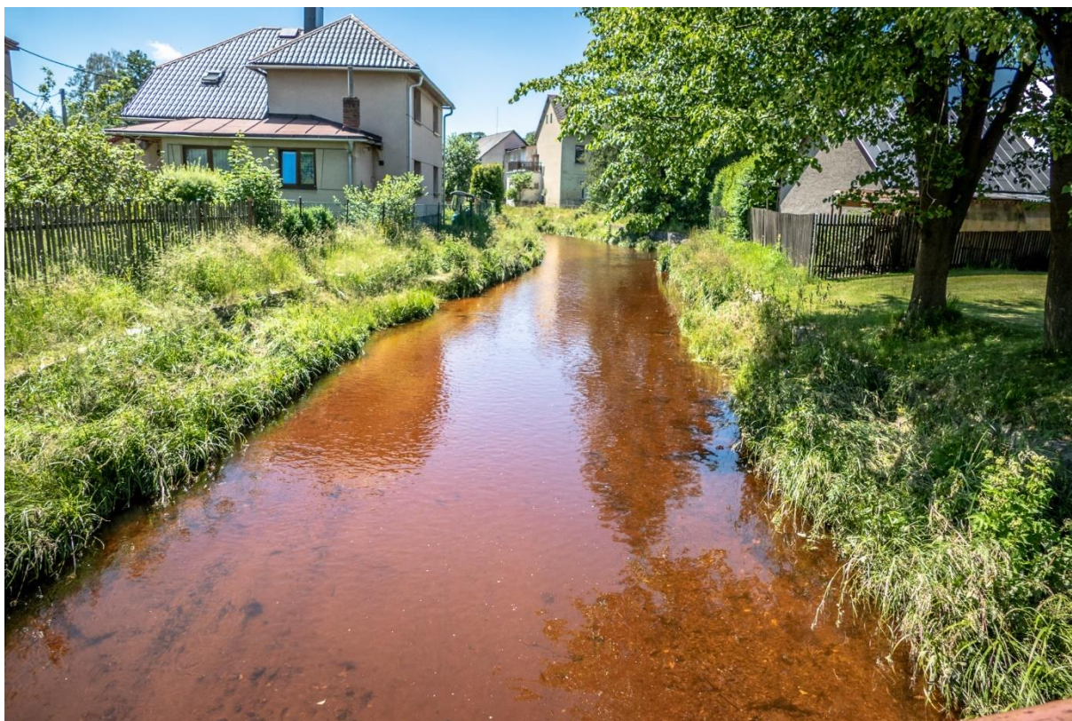
Obr. 50. Pohled z lávky L1, proti p., tvar připomínající složený lichoběžník, ř. km 165,9813 [6/2020].
