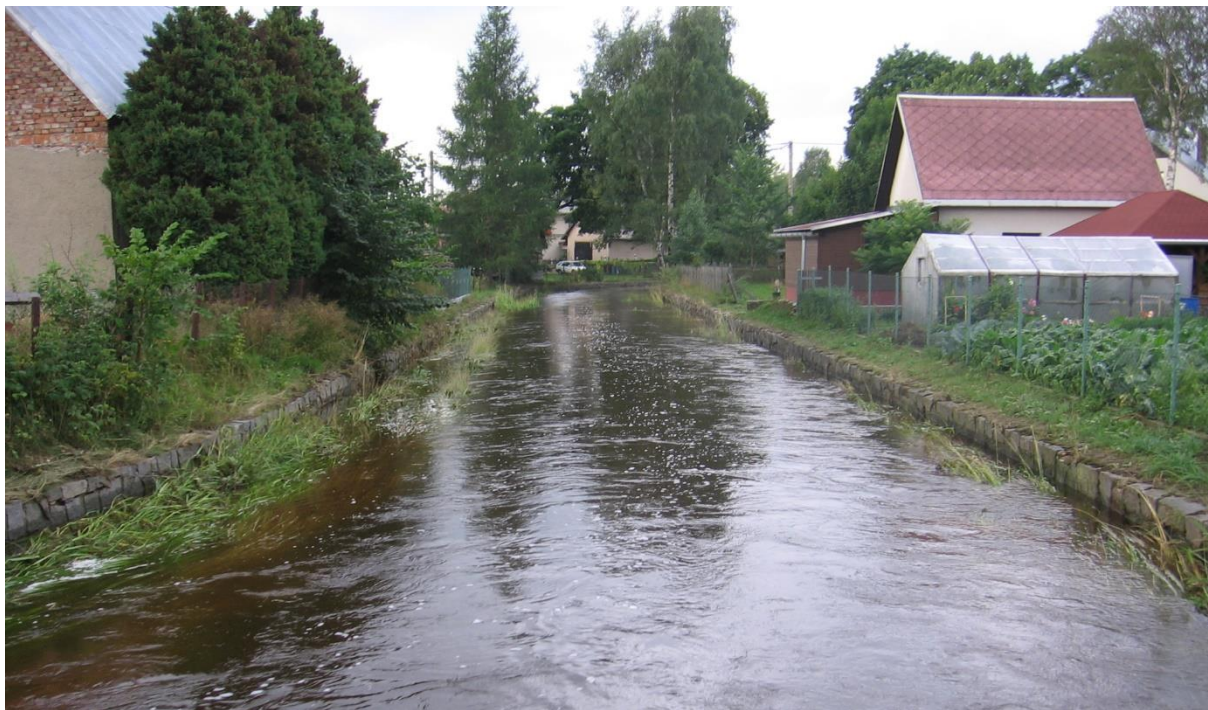
Obr. 21. Herálec – intravilán, pohled z lávky pro pěší, pohled po proudu, ř. km 165,9813. [foto: Ing. H. Uhmánová, CSc., 8/2016]
