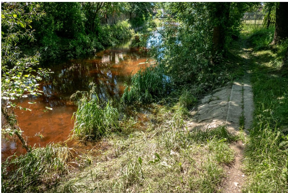
Obr. 47. Pohled z LB, proti p., přechod do intravilánu s oboustrannou zástavbou, ř. km 165,5982 [6/2020].
