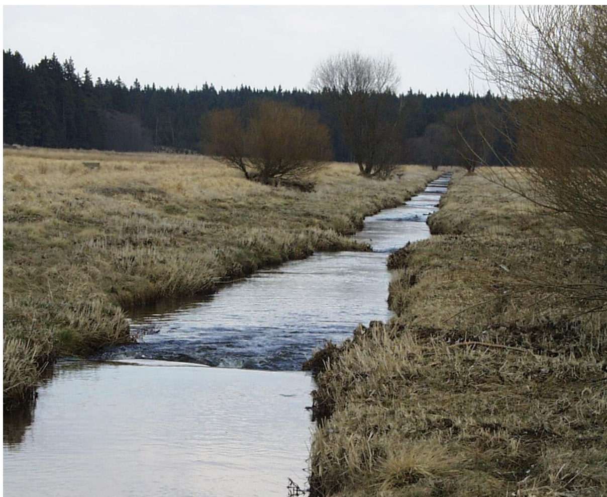
Obr. 31. Pohled z PB, po toku, známky chudého vegetačního doprovodu s příčnými dnovými prahy, přibližný ř. km 164,700. [foto: Ing. H. Uhmánová, CSc., 2010]
