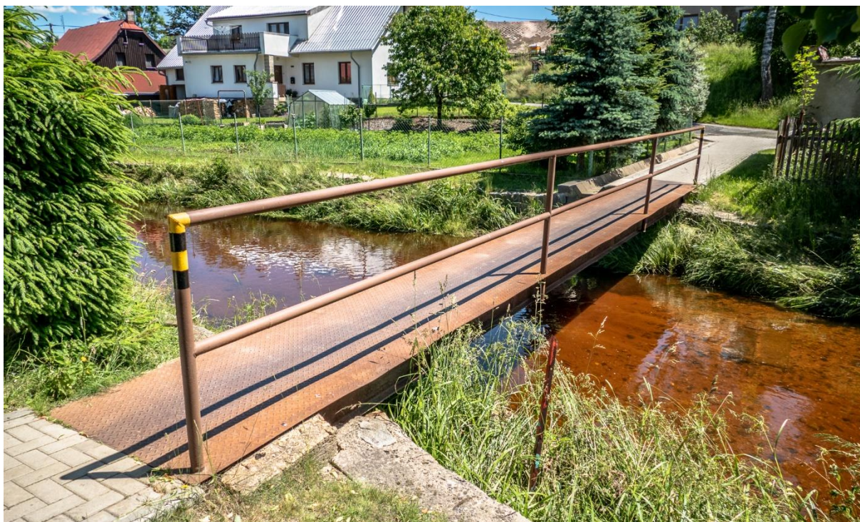
Obr. 60. L1 – Lávka, ř. km 165,9813 [6/2020].
