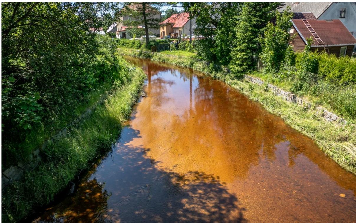
Obr. 54. Pohled z mostu M2, proti p., vegetace podél toku, ř. km 165,8499 [6/2020].
