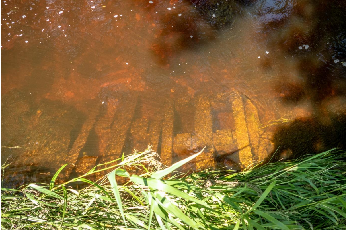
Obr. 38. Pohled z PB na technickou stabilizaci paty a svahu betonovými tvarovkami kynetě, taktěž sloužící jako rybí úkryty, přibližný ř. km 165,250 [6/2020].
