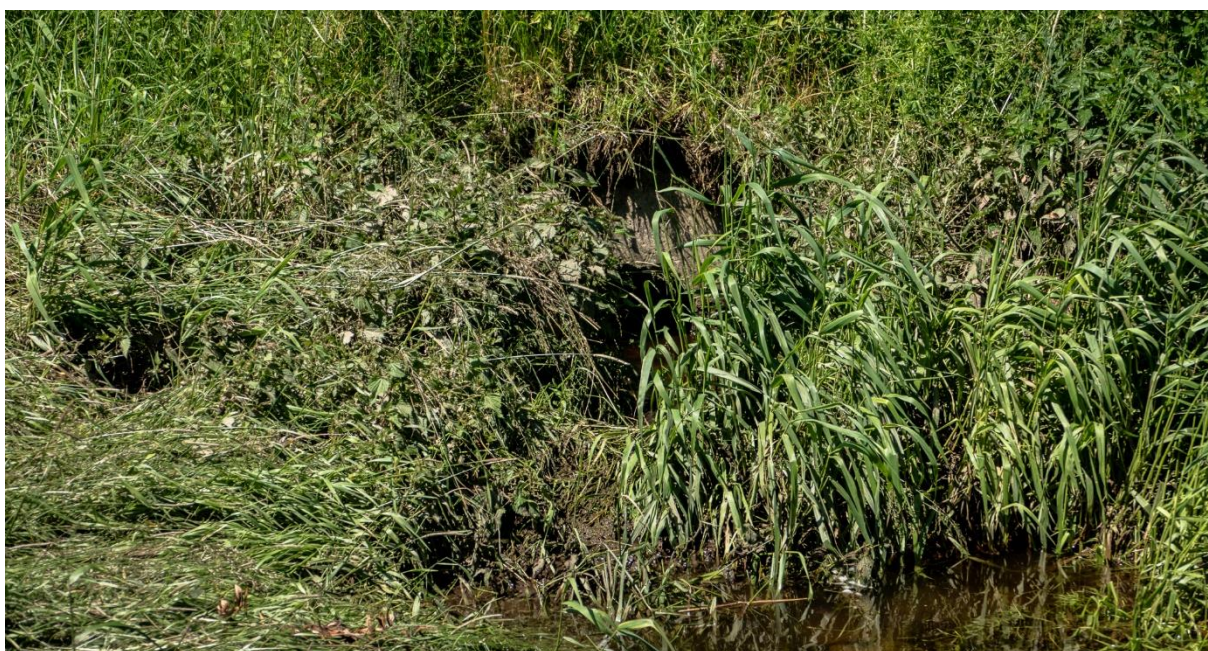
Obr. 46. Pohled z LB, PB výust drenáže, ř. km 165,2796 [6/2020].
