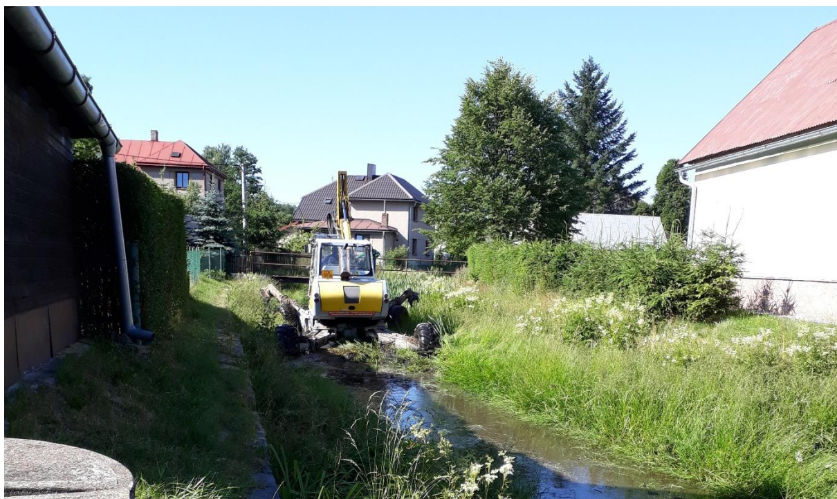
Obr. 52. Pohled z PB, proti p., odstraňování nánosů těžkou technikou, přibližný ř. km 165,9790 [foto: Ing. H. Uhmánová, CSc., 7/2019].
