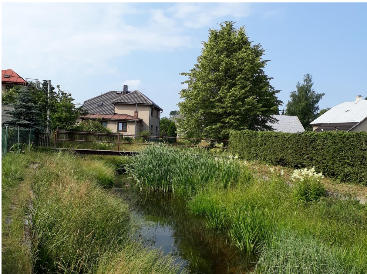
Obr. 51. Pohled z PB, proti p., vzrostlá vegetace v korytě, přibližný ř. km 165,9790 [foto: Ing. H. Uhmánová, CSc., 6/2018].
