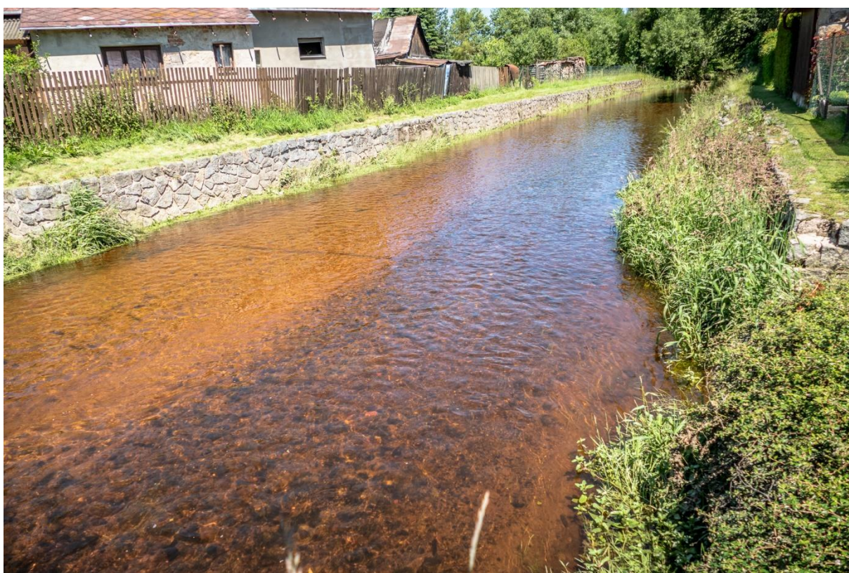
Obr. 53. Pohled z mostu M1, po p., ř. km 165,6747 [6/2020].
