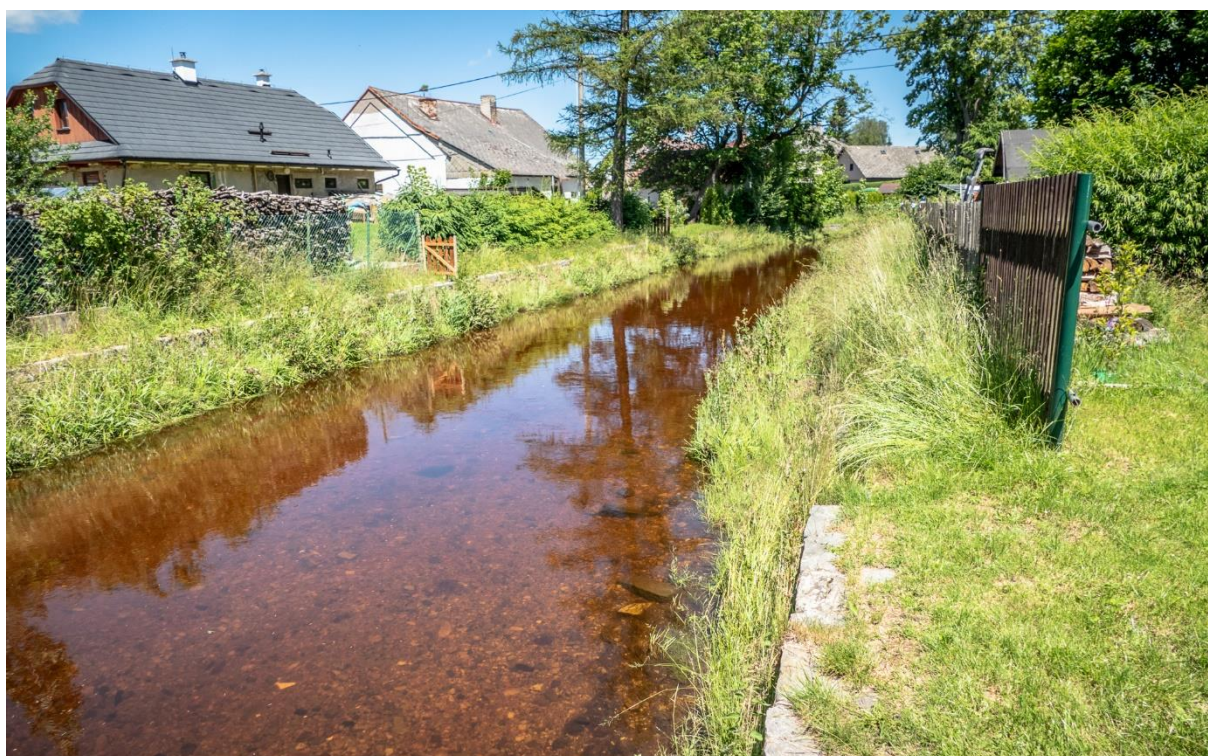
Obr. 49. Pohled z PB, po p., oboustranné nábřežní zdi, vyžděné z kamene a betonu, přibližný ř. km 165,900 [6/2020].
