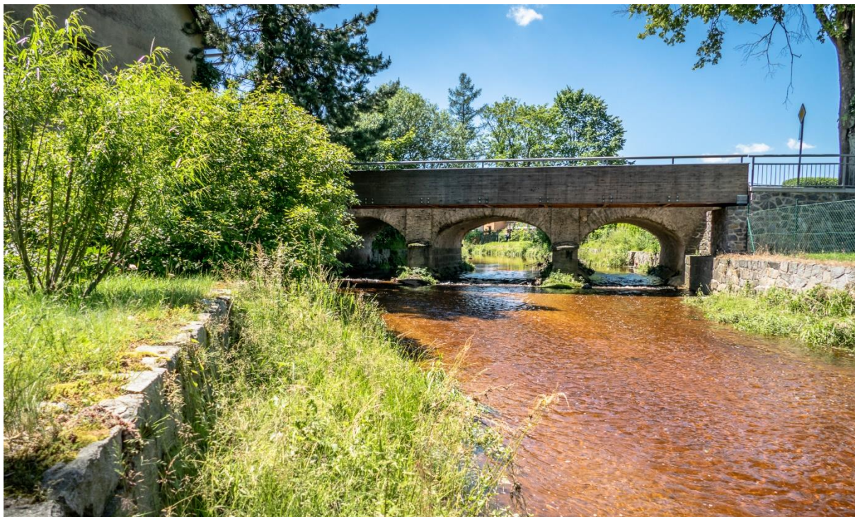
Obr. 59. M2 – Most, ř. km 165,8545 [6/2020].
