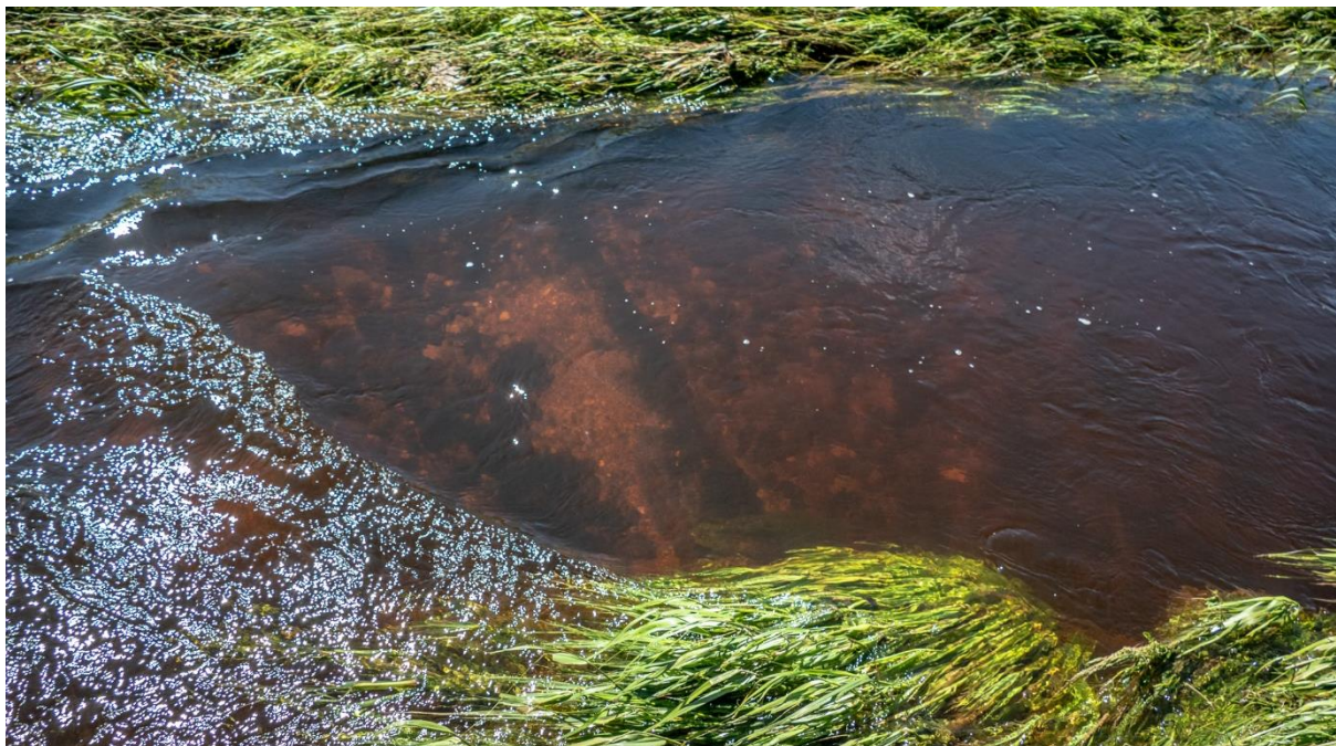
Obr. 45. Pohled z LB, proti p., dnový práh, ř. km 165,9745 [6/2020].
