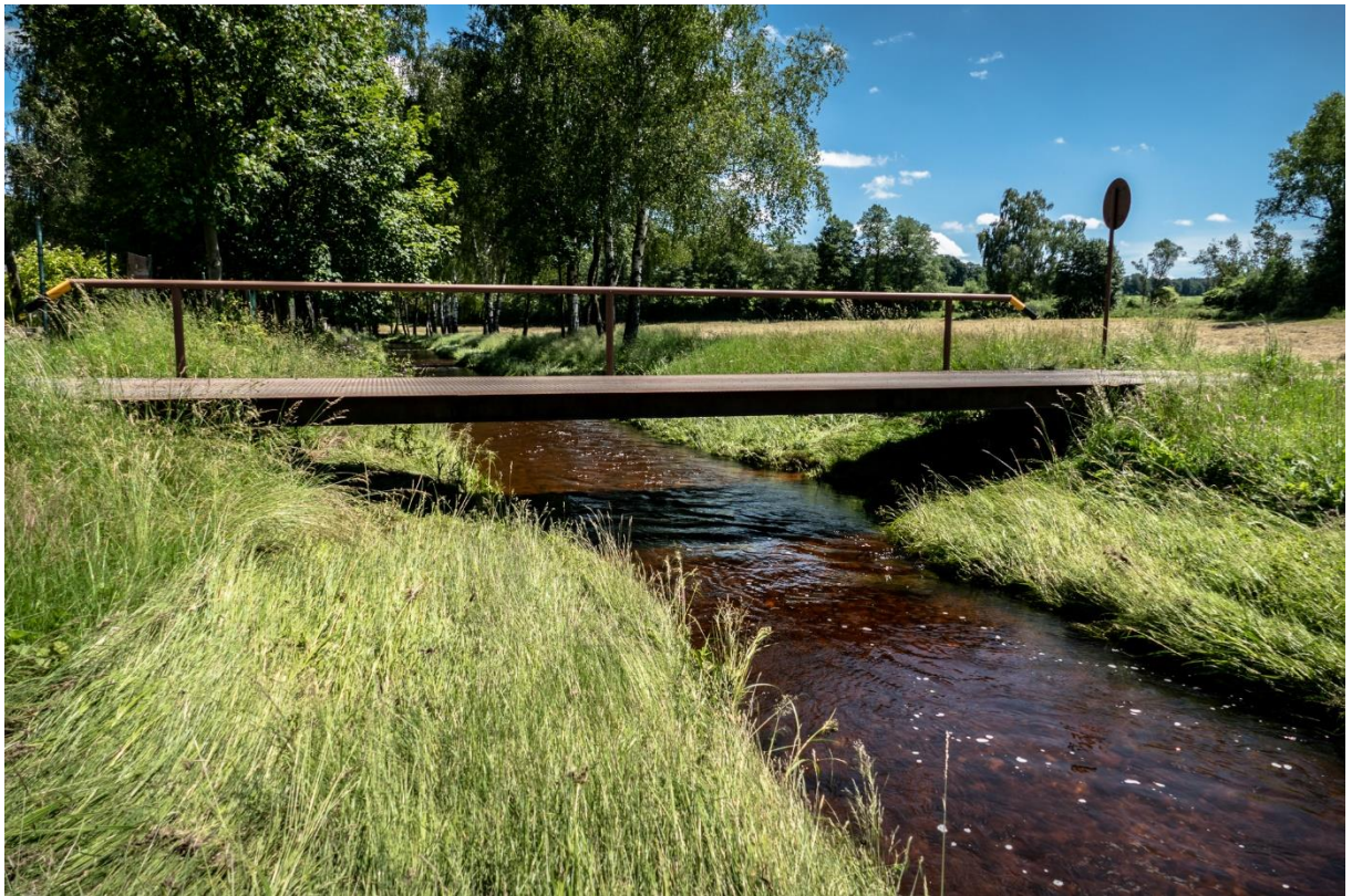
Obr. 66. L2 – Lávka, ř. km 166,4946 [6/2020].
