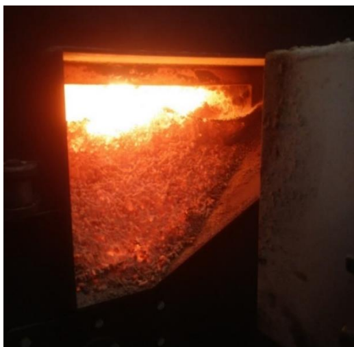
Obr. 3.14 Pohled do zplyňovací komory během spalovací zkoušky slámy
