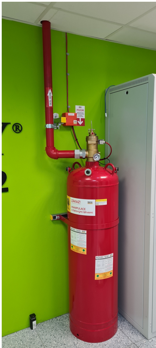
Obrázek 18: Hasicí tlaková nádoba
