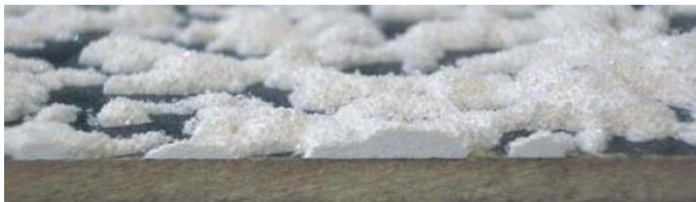
Obrázek 5 – Strukturální vodorovné dopravní značení (zblízka)
