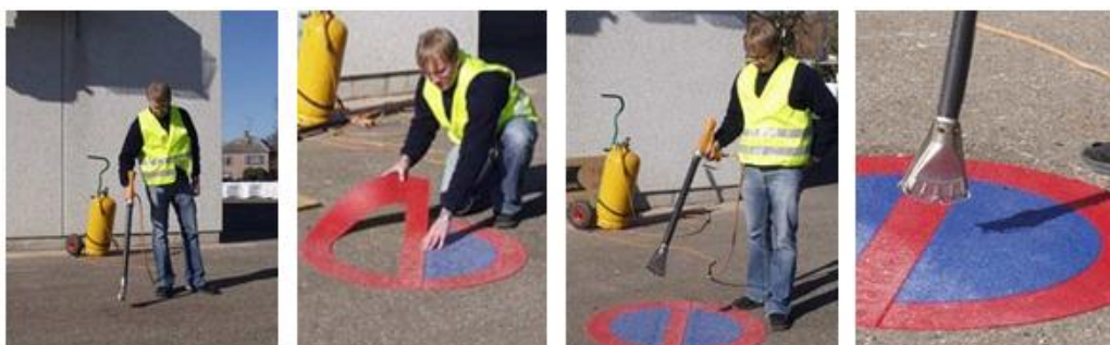
Obrázek 14 – Pokládka předformovaných termoplastických materiálů
