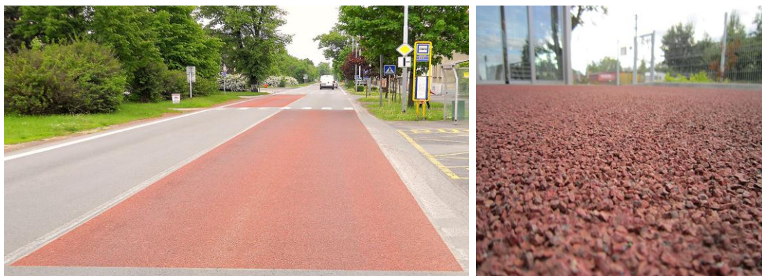
Obrázek 16 – Bezpečnostní protismyková úprava povrchů vozovek
