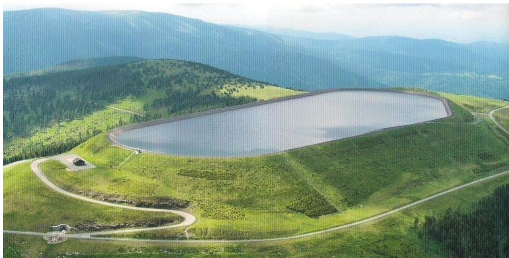
Obr. 10 Přečerpávací vodní elektrárna Dlouhé Stráně (Benda a kol., 2012)
