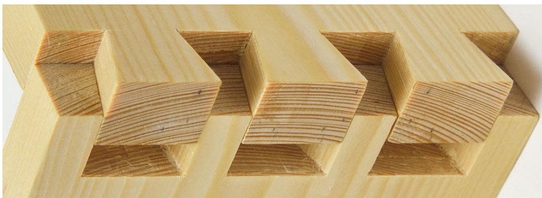
Obr. 17 Otevřené rybinové ozuby v příčném spoji.
