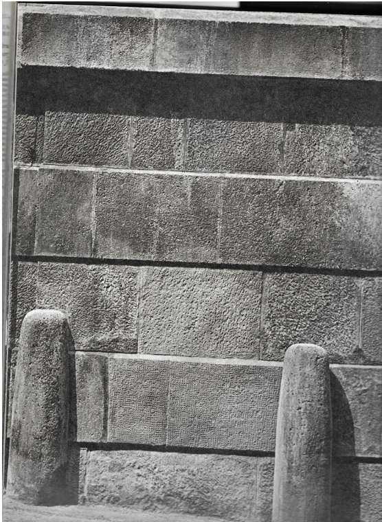
Obr. 53. Detail podnože boční fasády, kostel sv. Mikuláše, Malá Strana
