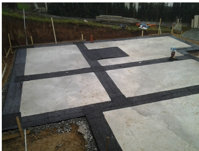
Obrázek 5 Pokládka pásů pod nosné zdi - ilustrační foto zdroj: http://www.zem-salom.cz/fotogalerie.html
