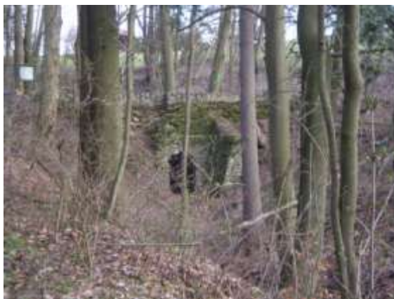
Obr. 10 Kubův most, který býval součástí „Železné cesty“, která sloužila k manipulaci se železnou rudou
