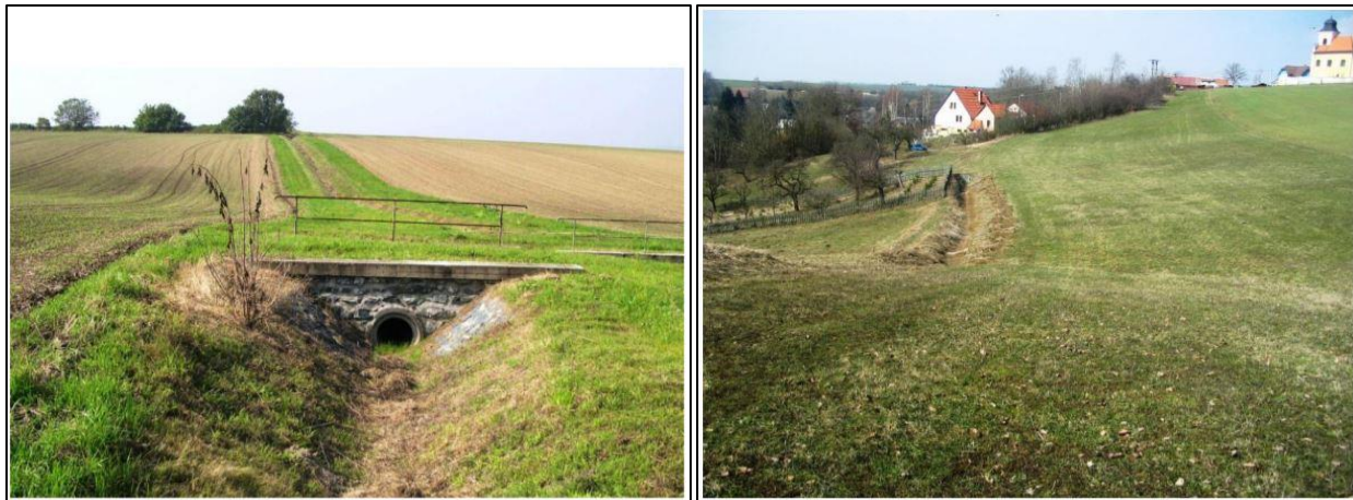
Obrázek 5: Příklad svodného (vlevo) a záchytného (vpravo) příkopu, (zdroj: Kadlec et al. 2014)
