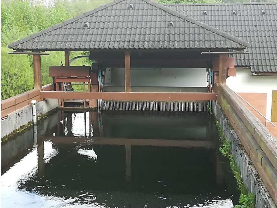
Obrázek 23 - Vtokový objekt do MVE Dolní Branná s česlemi a propustí [28]
