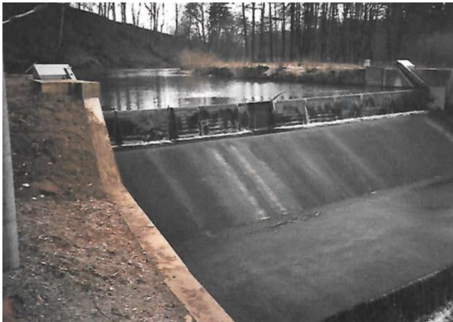
Obrázek 25 - Fotografie z průběhu rekonstrukce jezu a navýšení jezové klapky [28]
