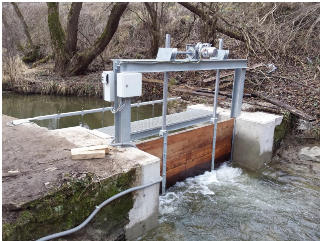
Obrázek 8 - Stavidlo s rybí zábranou u MVE Šlapanov [37]
