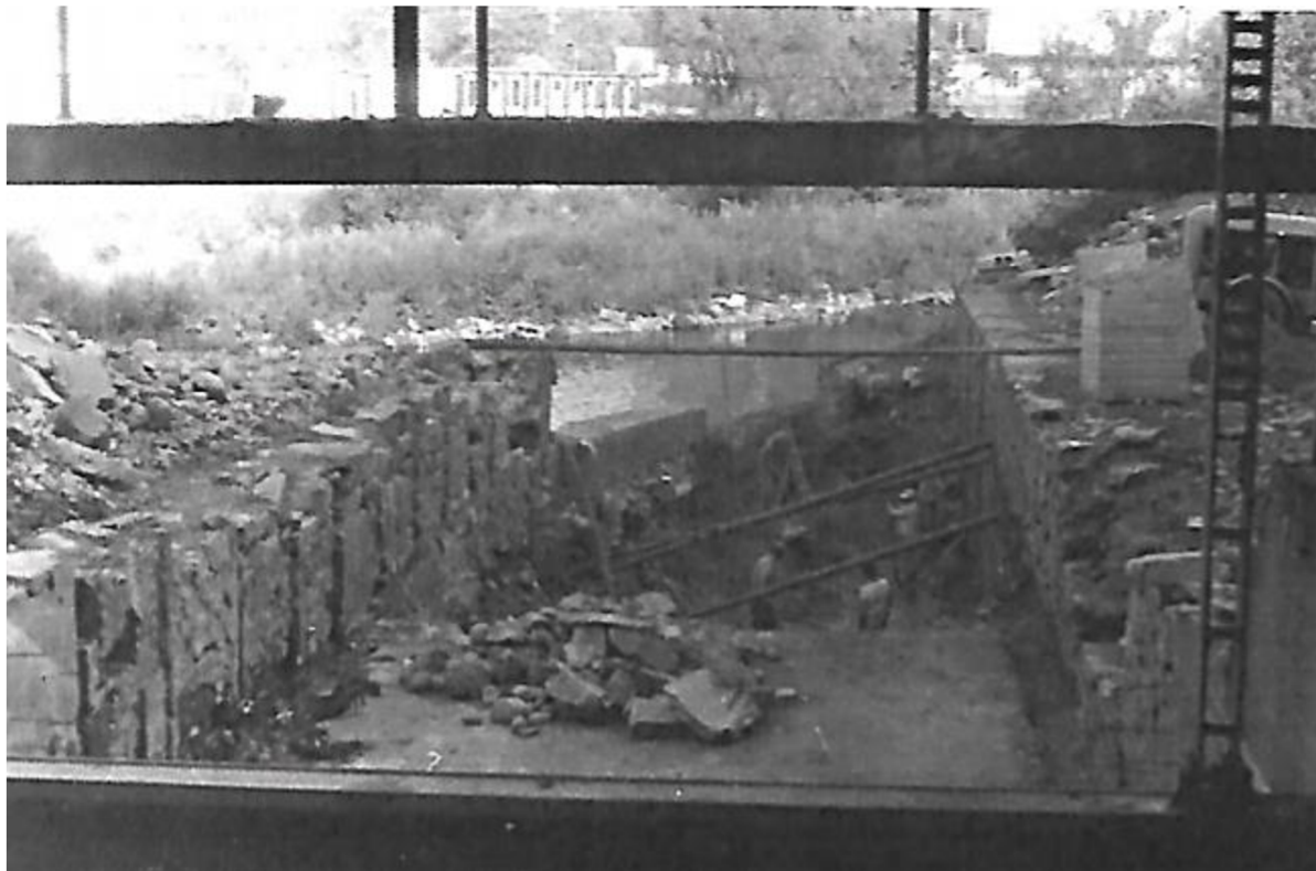
Obrázek 21 - Výstavba vtokového objektu MVE Dolní Branná v roce 1990 [28]
