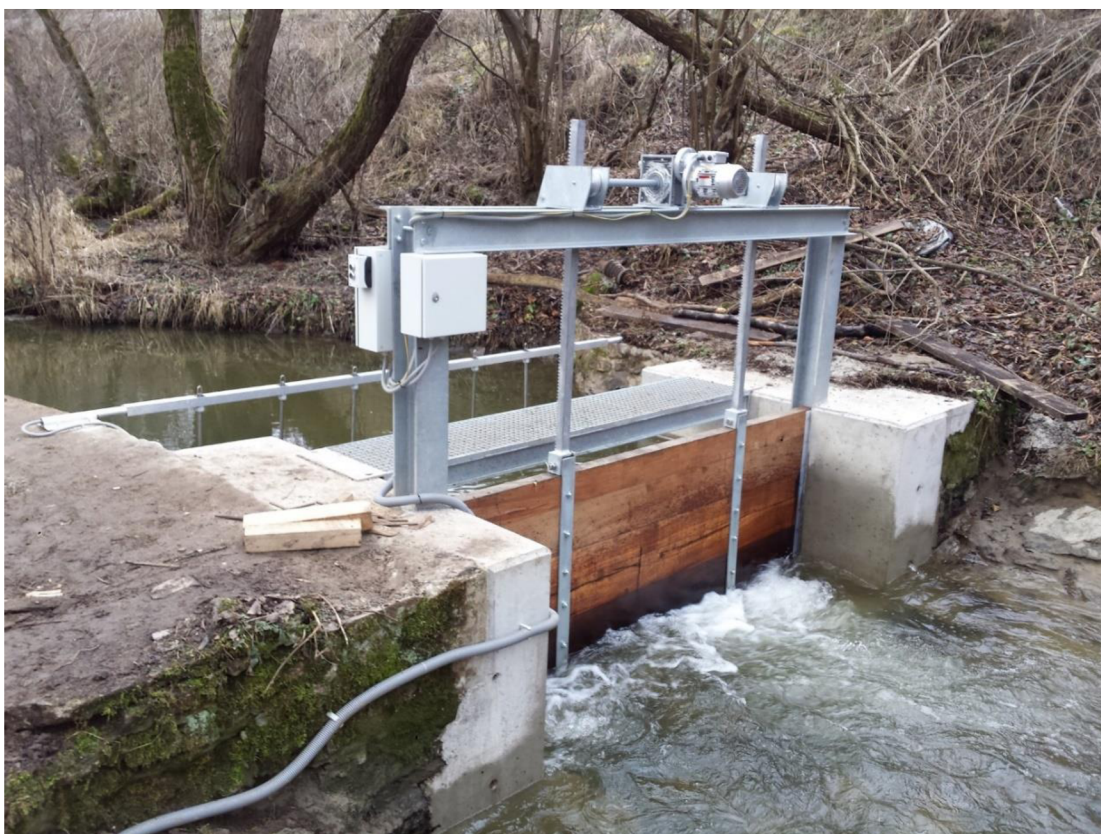
Obrázek 8 - Stavidlo s rybí zábranou u MVE Šlapanov [37]
