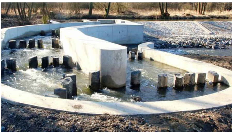
Obrázek 10 - Moderní rybí přechod na řece Šlapance, který odvádí ryby mimo jez [39]
