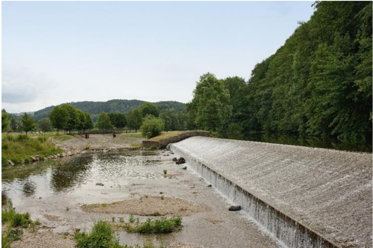
Obrázek 9 - Vliv přílišného odebrání vody do MVE Ivančice na řece Jihlavě [38]
