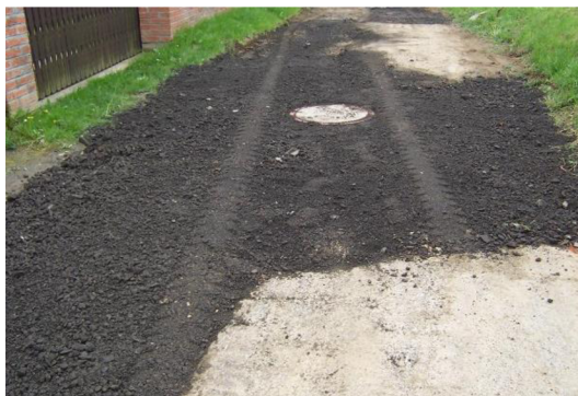
Obrázek 27: Oprava komunikace vsypem živičného recyklátu [37]
