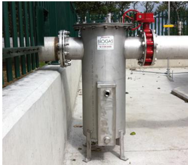
Obr. 11 Odlučovač kapek [31]
