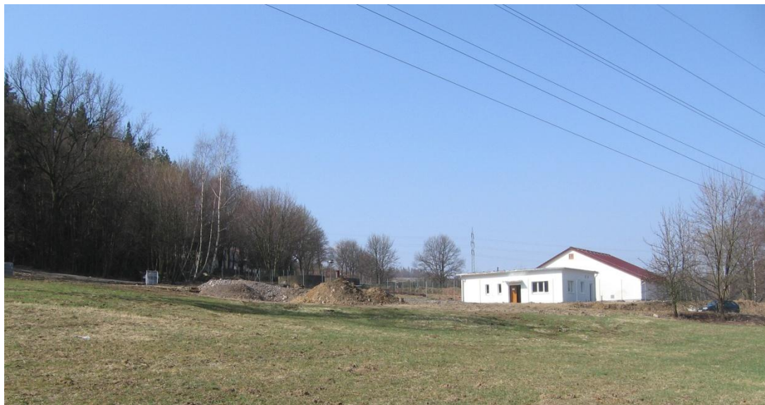
Obr. č. 20: ČOV Milín, umístění IP č. 11, zdroj: vlastní foto
