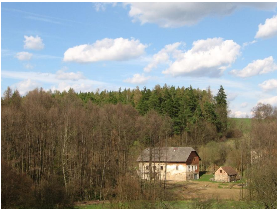
Obr. č. 19: Bývalý mlýn Kotalík, předpokládané umístění IP č. 10, zdroj: vlastní foto
