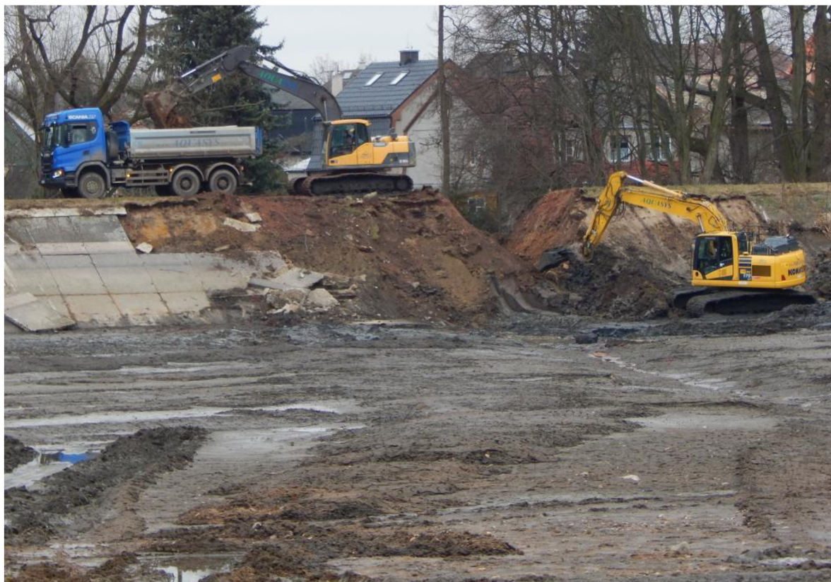
Obr. 8 Revitalizace rybníku Proboštov v lednu 2022 (zdroj: www.ouprobostov.cz )
