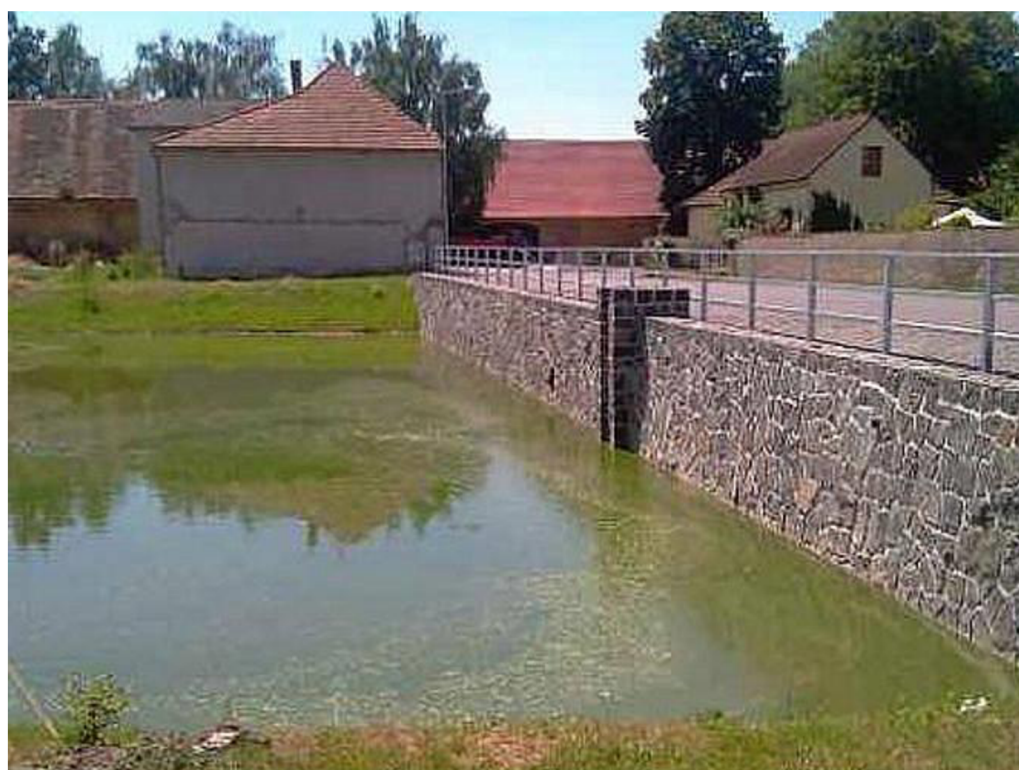
Obr. 11 Hráz rybníka Budyně nad Ohří (zdroj: www.litomerickydenik.cz )
