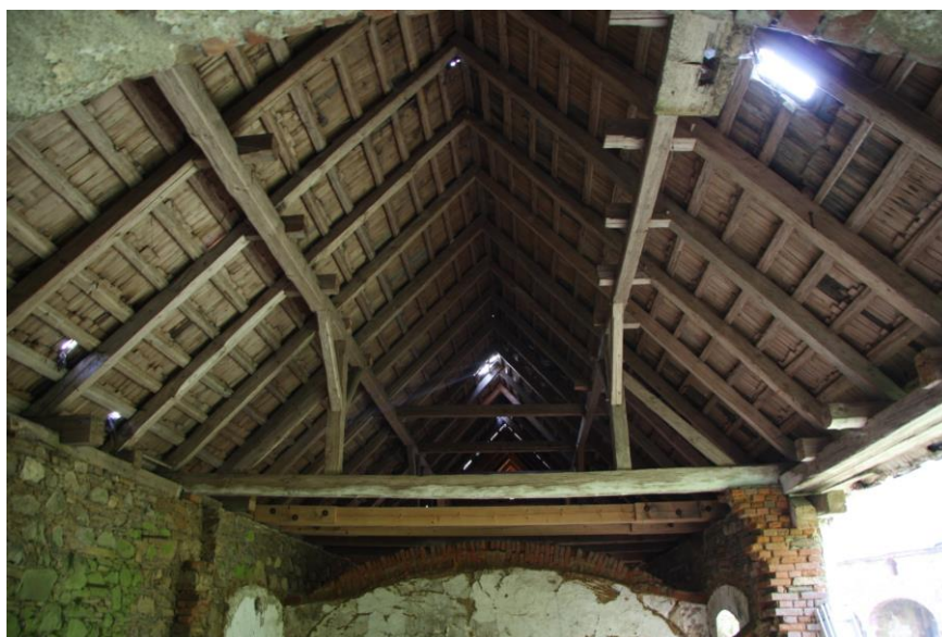
Obrázek č. 26 – Statek Vysočany - krov budovy B nad hospodářskou částí (Augusta, 2012)
