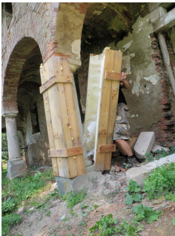
Obrázek č. 28 – Vytvoření formy sloupu (Augustová, 2013)
