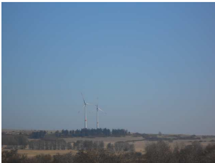
Obr.č.8 druhý bod – čerpací stanice Medos
