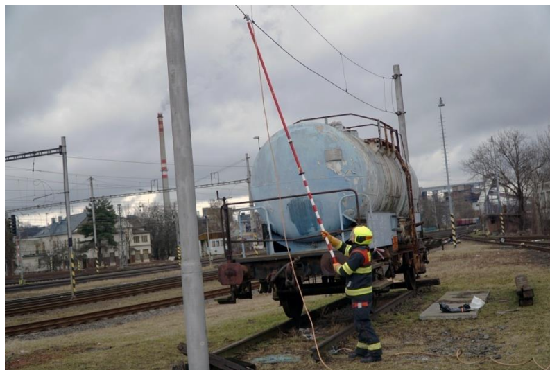
Obrázek 26 Zkratování trakčního vedení (zdroj: autor)
