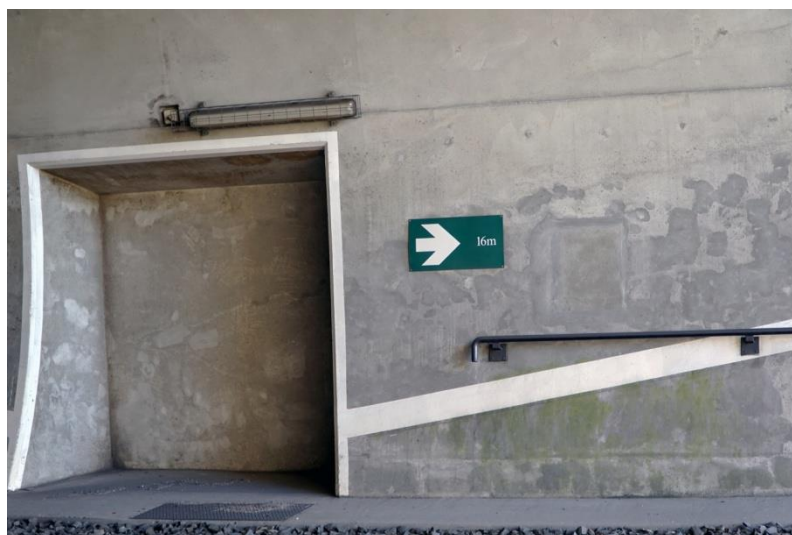
Obrázek 18 Evakuační cedule s počtem zbývajících metrů k východu z tunelu (zdroj: autor)
