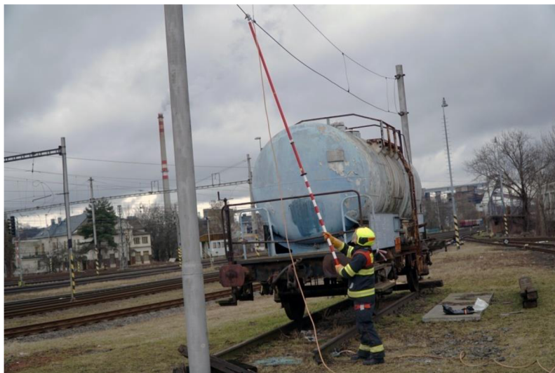
Obrázek 26 Zkratování trakčního vedení (zdroj: autor)
