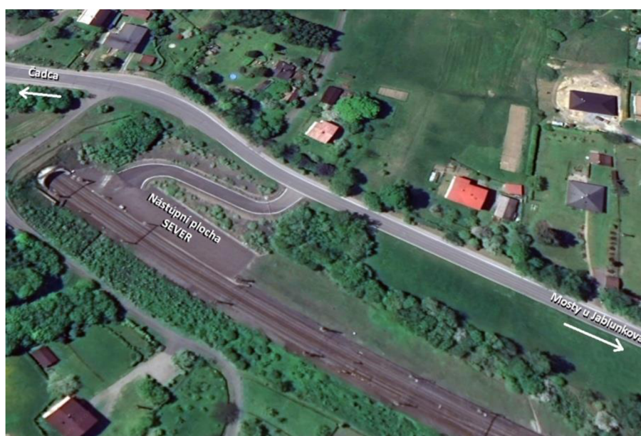
Obrázek 21 Příjezdová komunikace ze severní strany tunelu (zdroj: https://earth.google.com/ )
