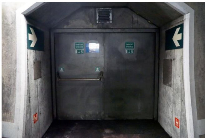
Obrázek 17 Dveře mezi tunelovým tubusem a propojovacím tunelem (zdroj: autor)
